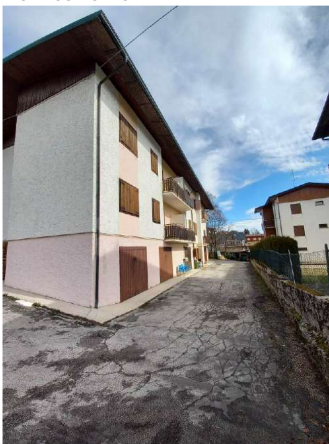
VISTA SUD OVEST
