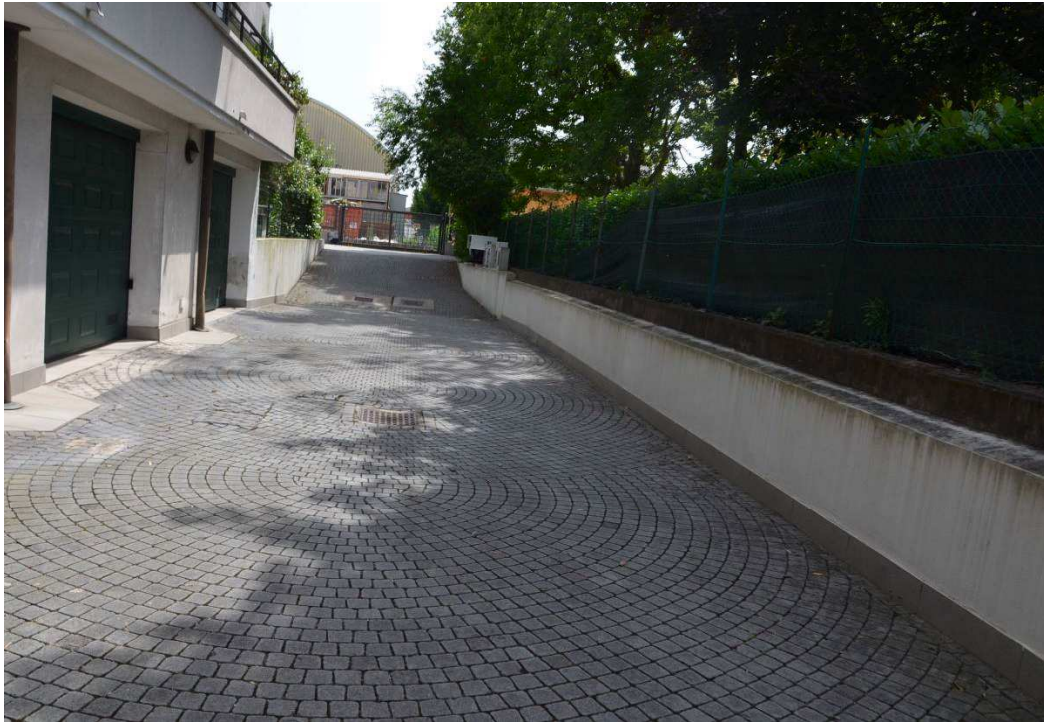
Rampa accesso garage da via Campania
