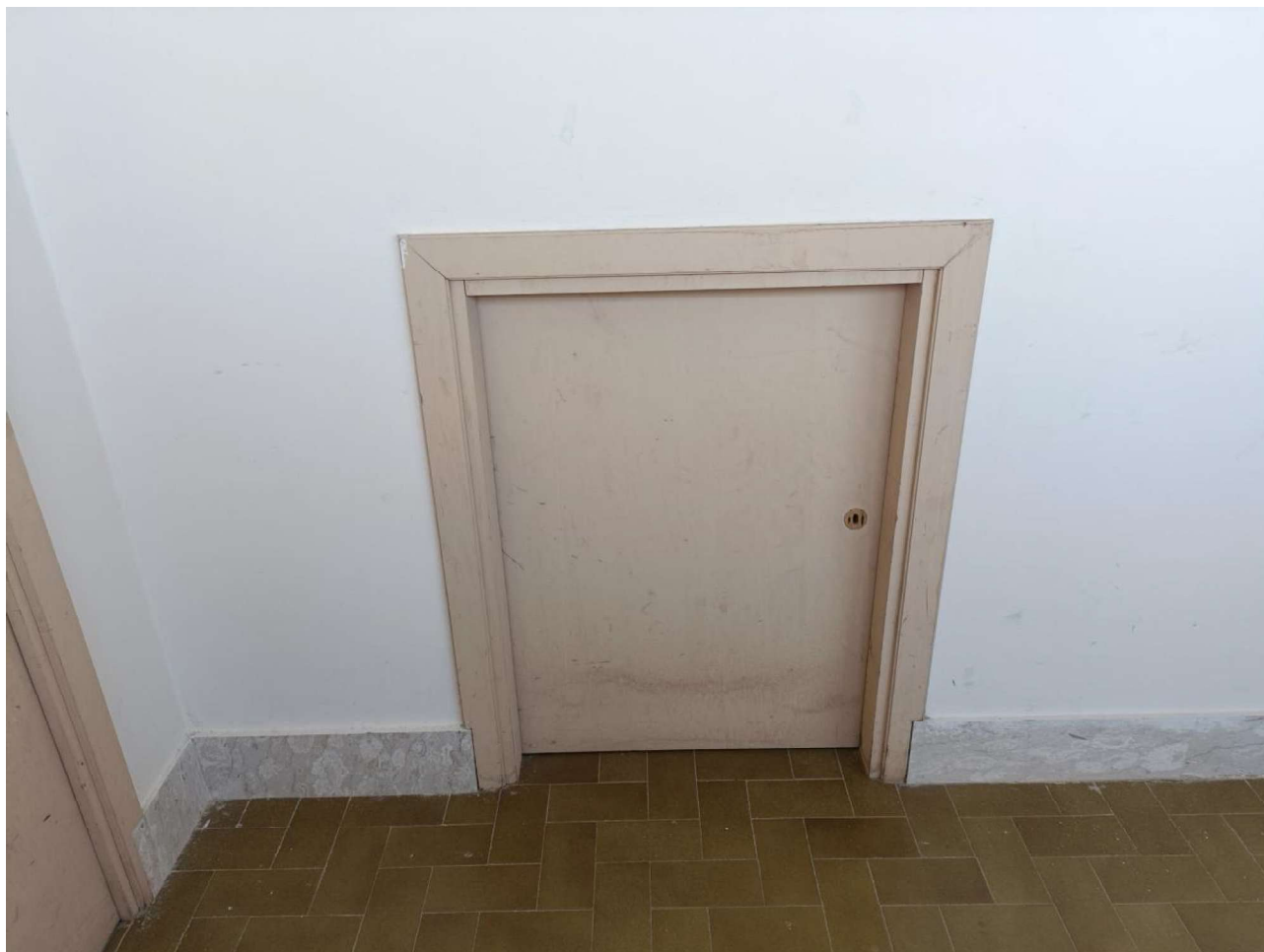
Figura 16 – Ingresso Locale Sottotetto.
