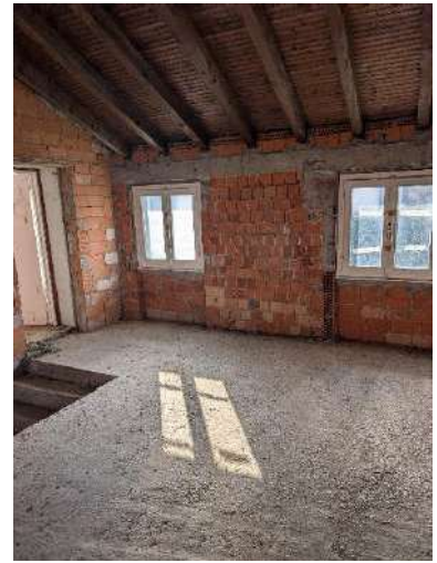
vista del locale al primo piano
