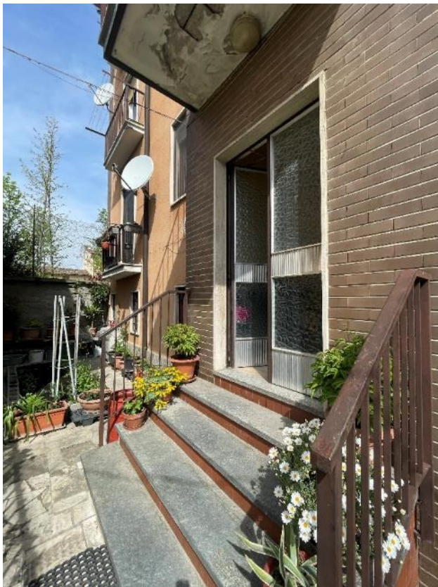
Scale di accesso al fabbricato
