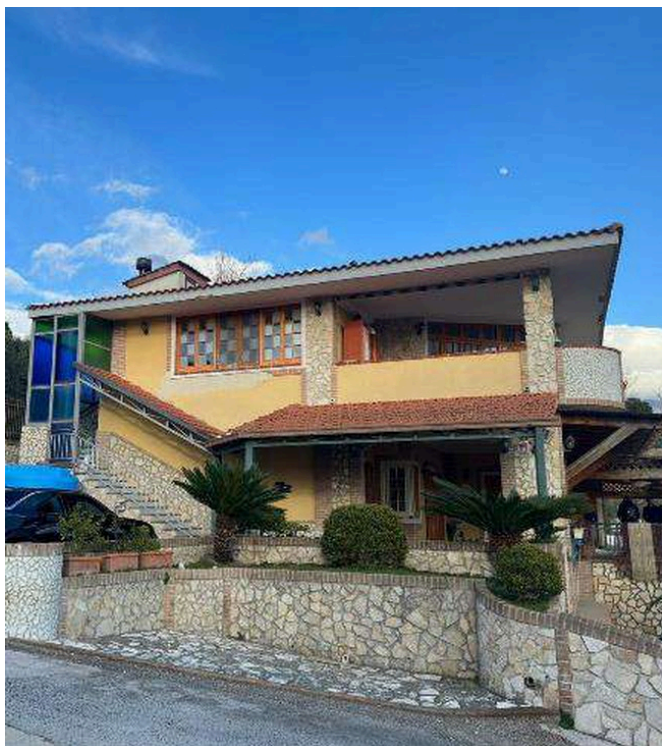
Foto n. 1 - Vista prospetto ovest lato ingresso
