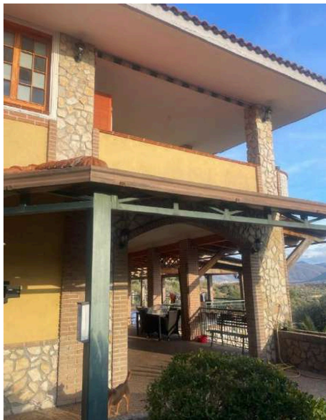
Foto n. 2 - Vista prospetto ovest lato ingresso
