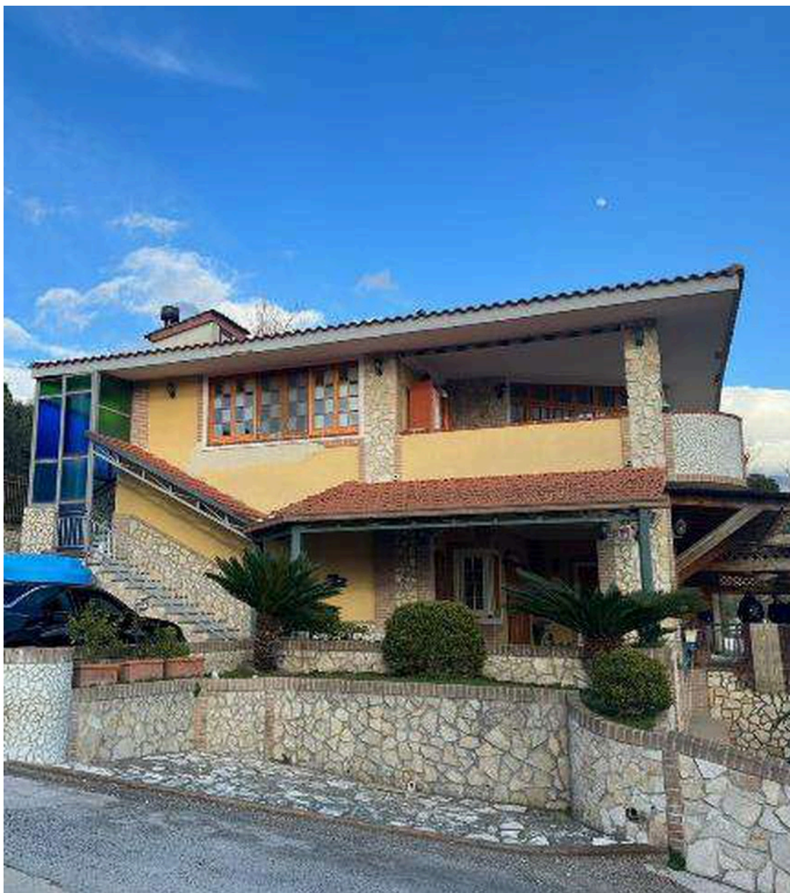
Foto n. 1 - Vista prospetto ovest lato ingresso
