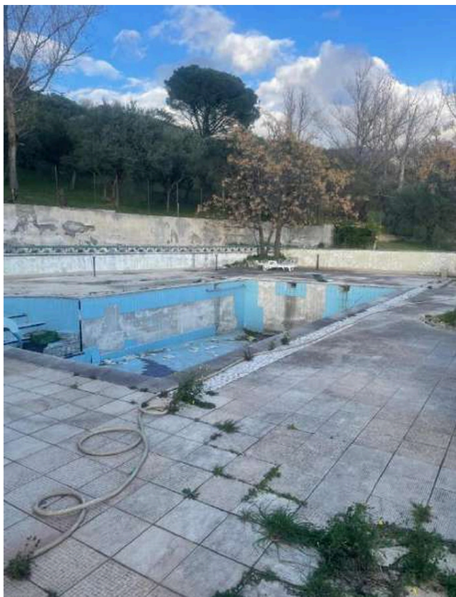
Foto n. 7 - Vista lato piscina
