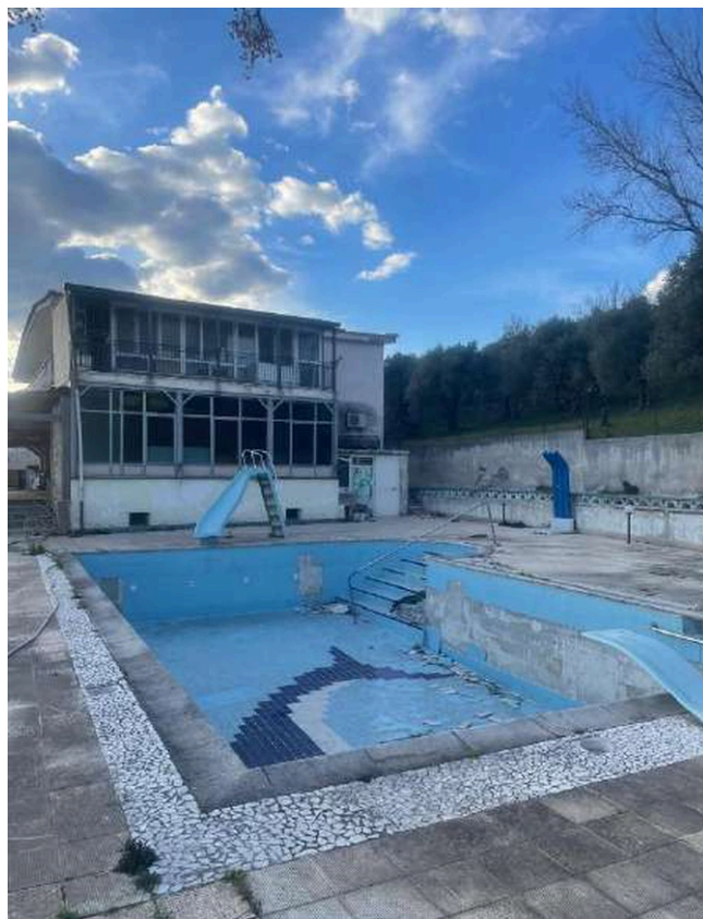
Foto n. 6 - Vista lato piscina
