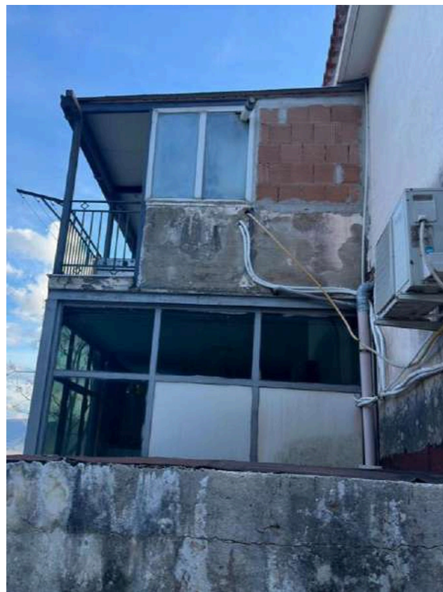
Foto n. 8 - Vista prospetto est veranda
