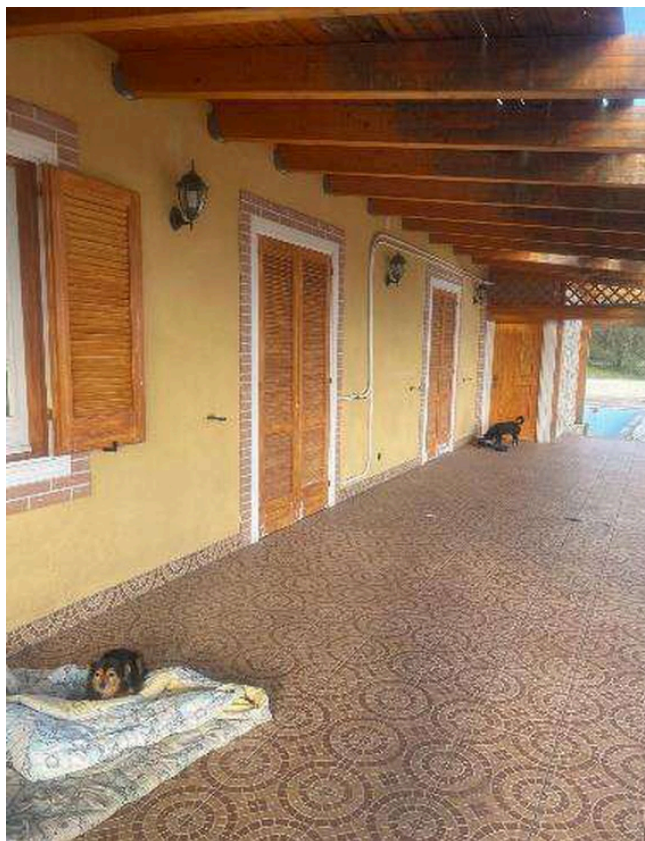
Foto n. 4 - Vista ingresso terrazzo
