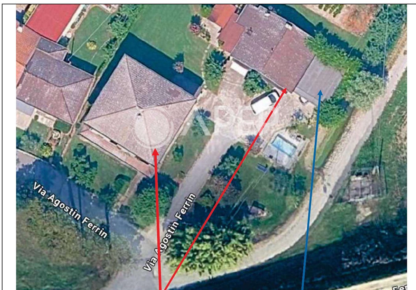
Foto n°4: Vista aerea dei due subalterni con vista aerea della tettoia abusiva
