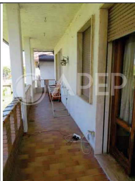
Foto n°18: Loggiato a sud
