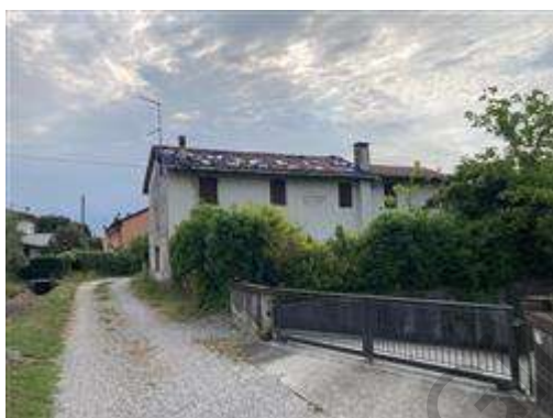
vista esterna dalla strada di accesso
