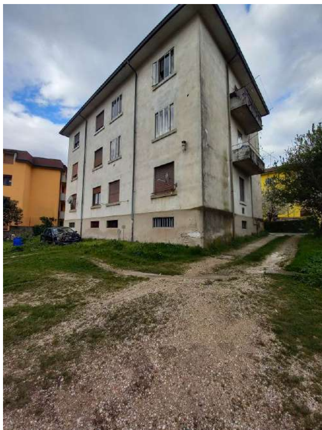
VISTA NORD EST
