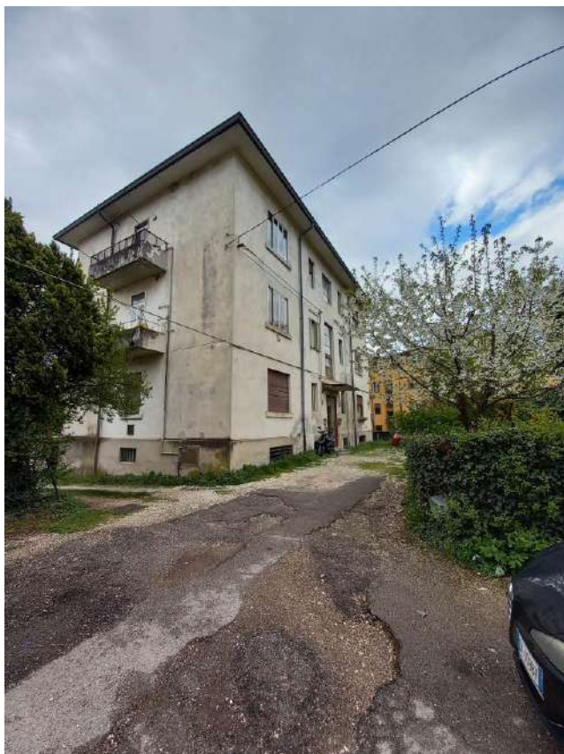
VISTA SUD EST
