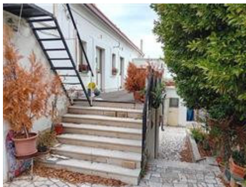
Scala di accesso al terrazzo
