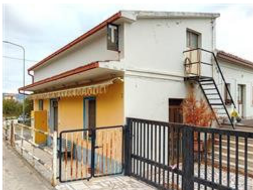
Esterno con cancello d'ingresso
