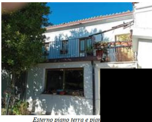
Esterno piano terra e piano primo
