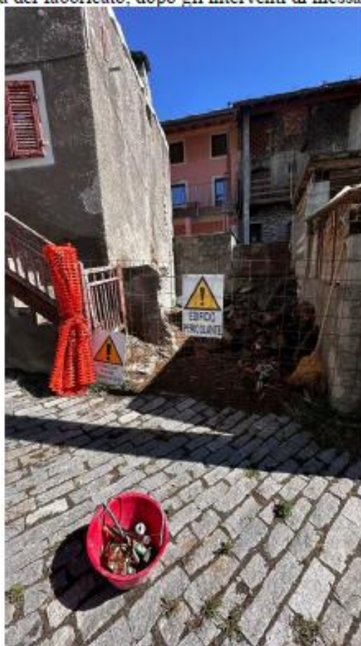
Vista esterna del fabbricato, dopo gli interventi di messa in sicurezza.
