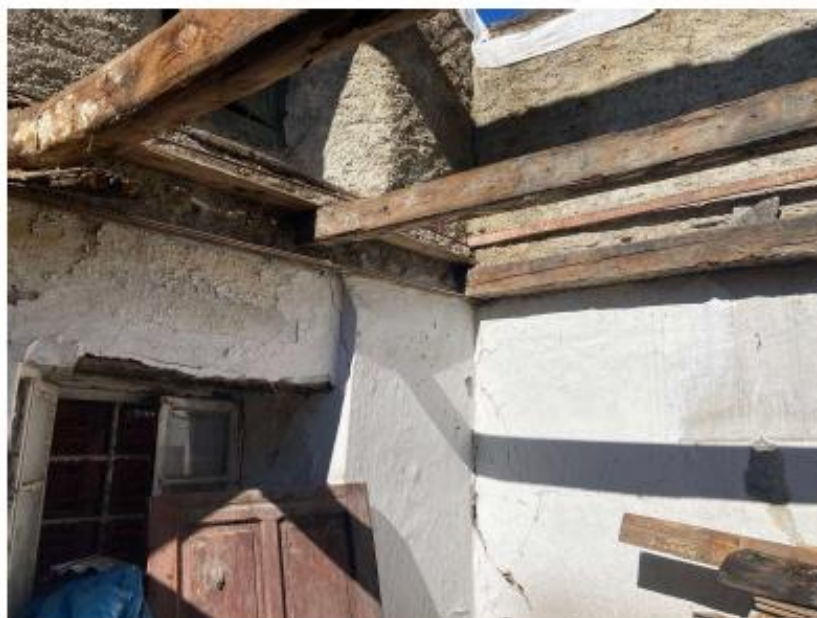
Vista interna del fabbricato, dopo gli interventi di messa in sicurezza.
