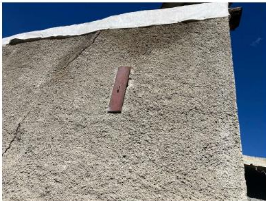
Vista esterna del fabbricato, dopo gli interventi di messa in sicurezza.
