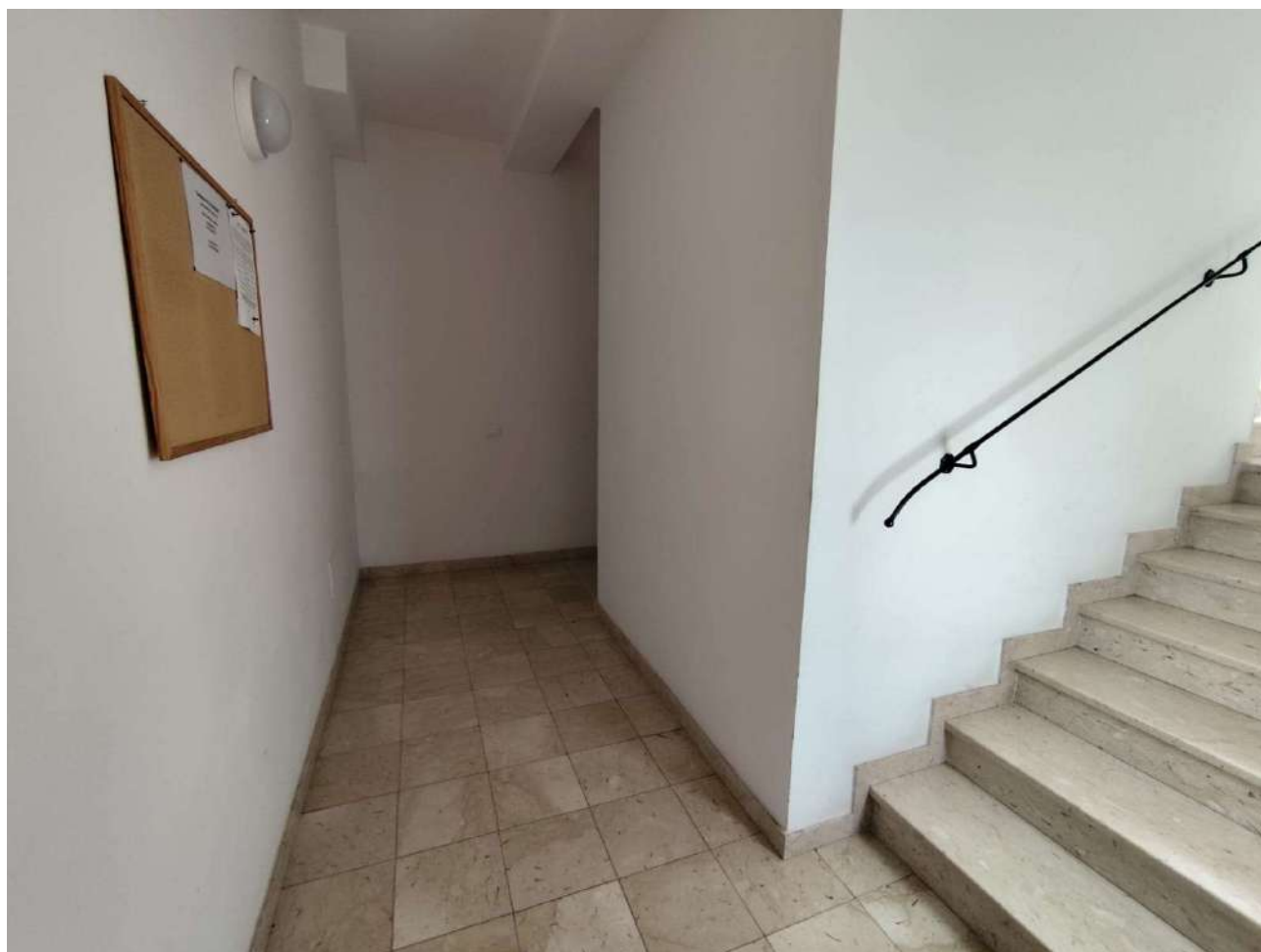
Ingresso vano scale
