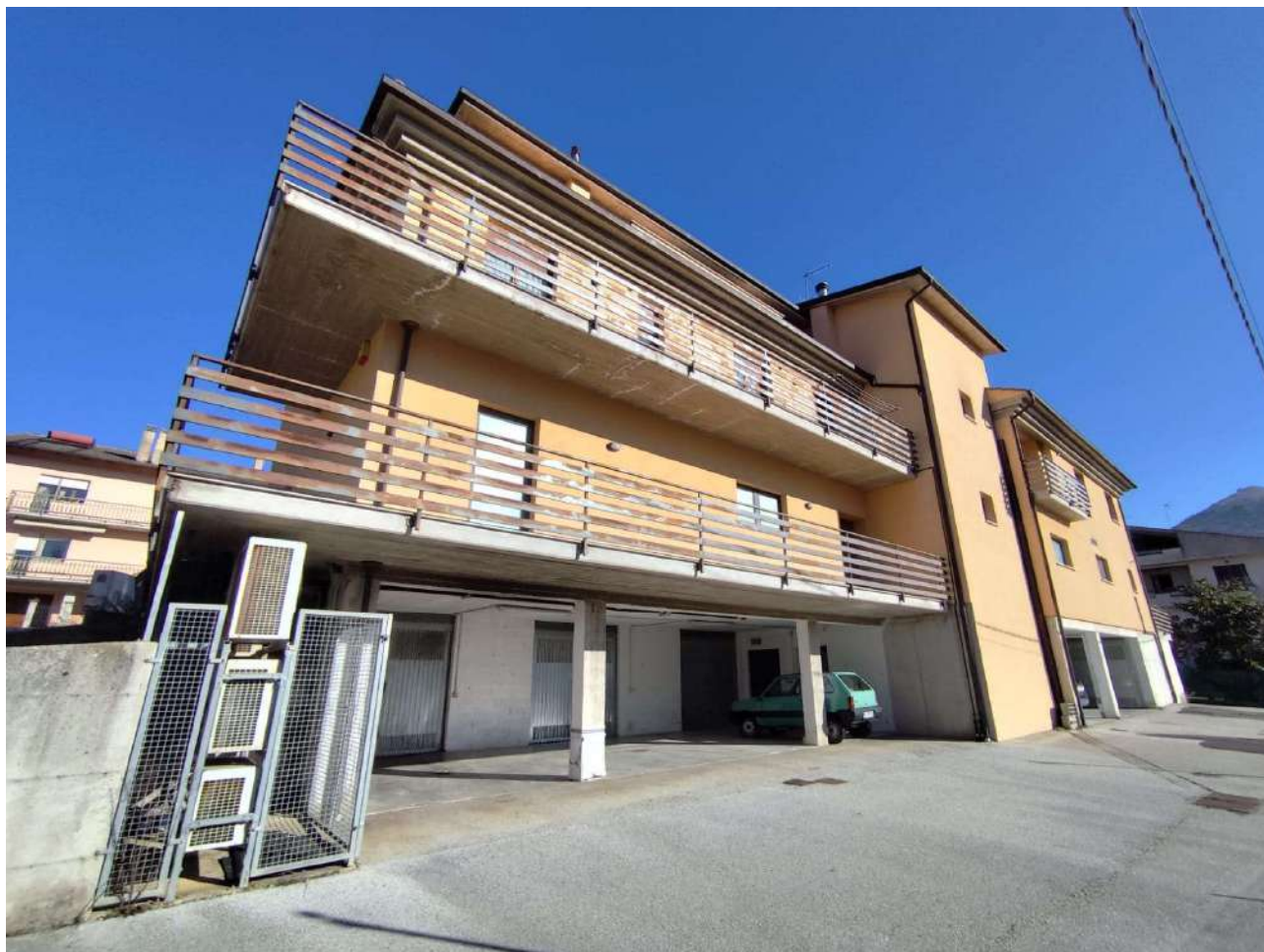
Esterno dell'edificio – retro
