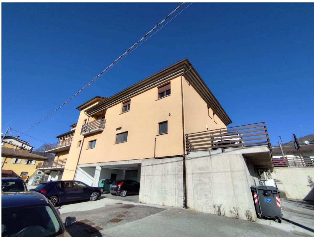
Esterno dell'edificio – retro
