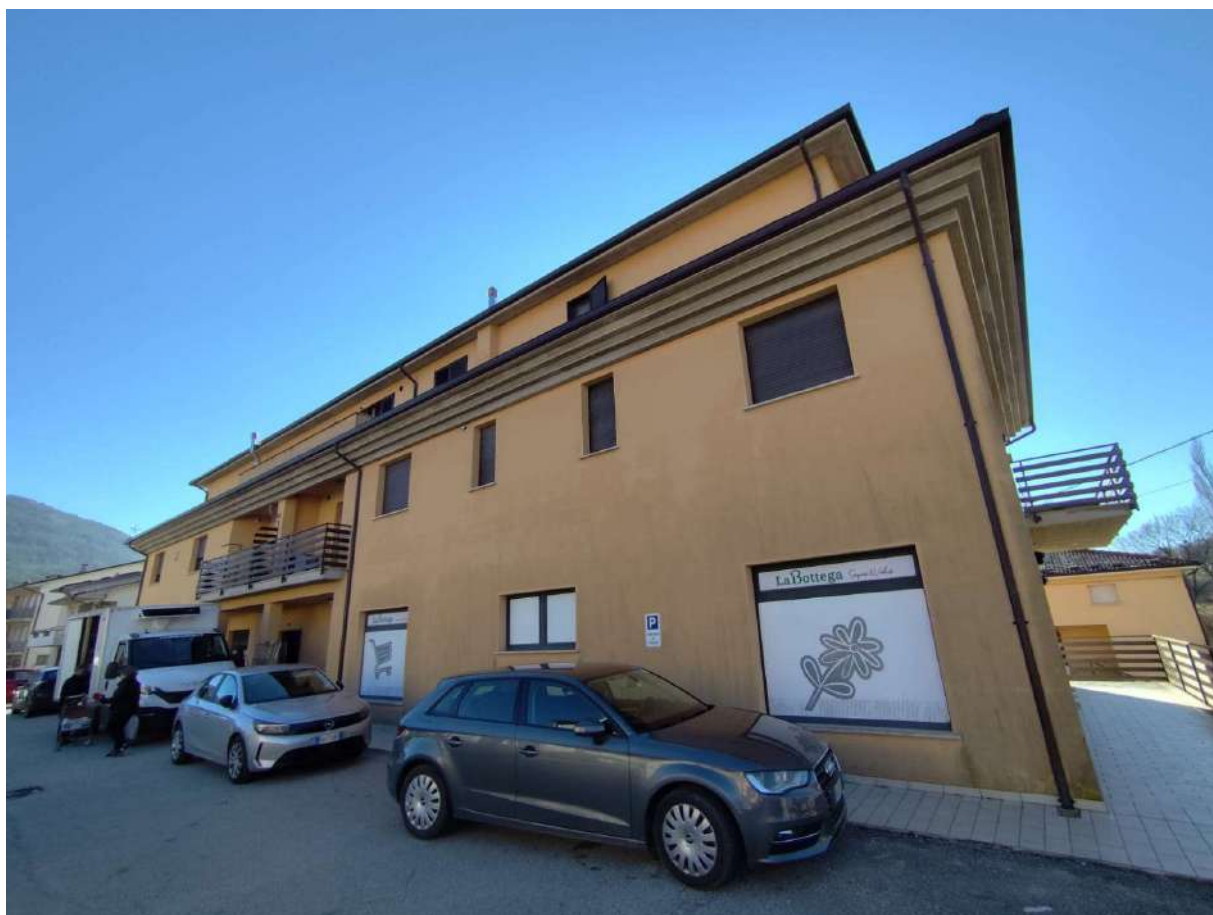
Esterno dell'edificio – fronte strada
