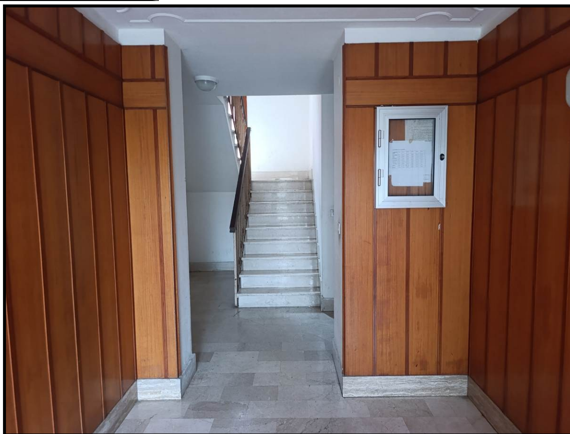
FOTO 3 – VANO SCALA COMUNE
