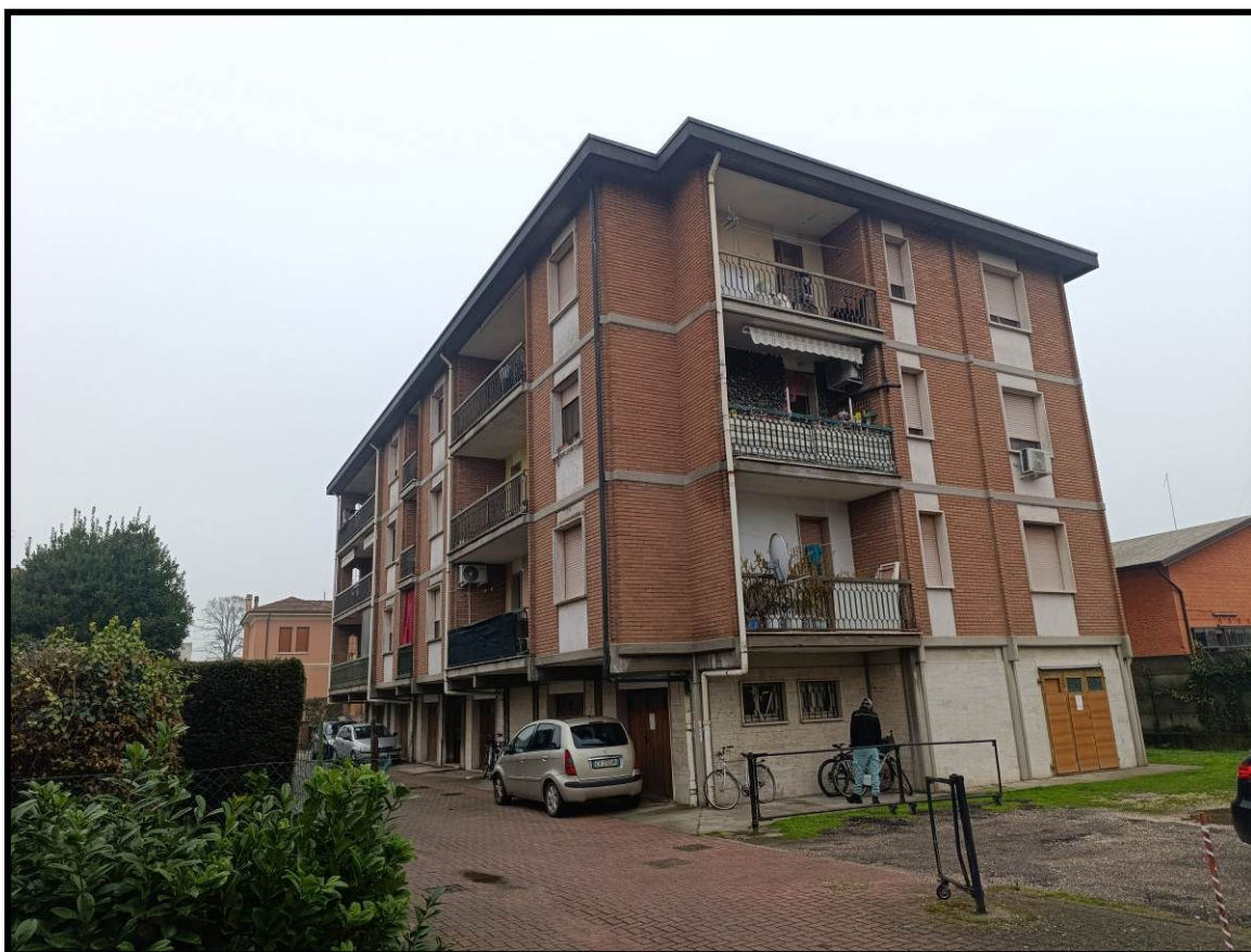
FOTO 14 – VISTA PROSPETTO RETRO
