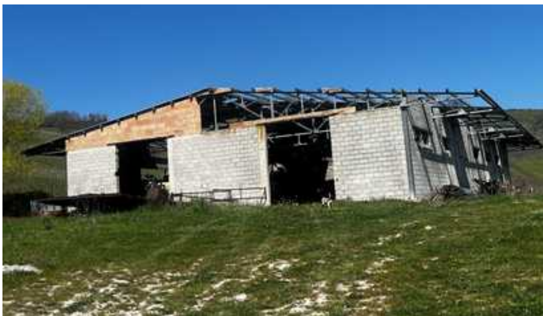
FOTO 4: VISTA DA SUD-EST
