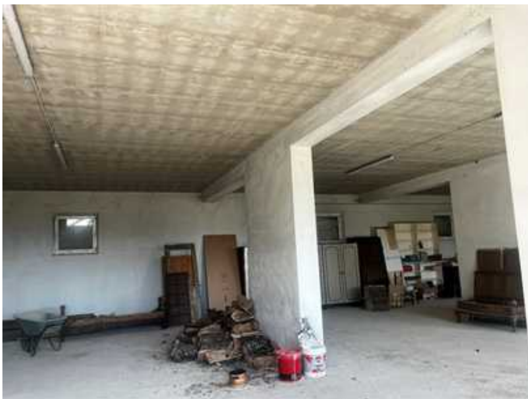
FOTO 6: VISTA, verso Nord, DALL'INGRESSO DEL DEPOSITO AL DI SOTTO DELL'ABITAZIONE
