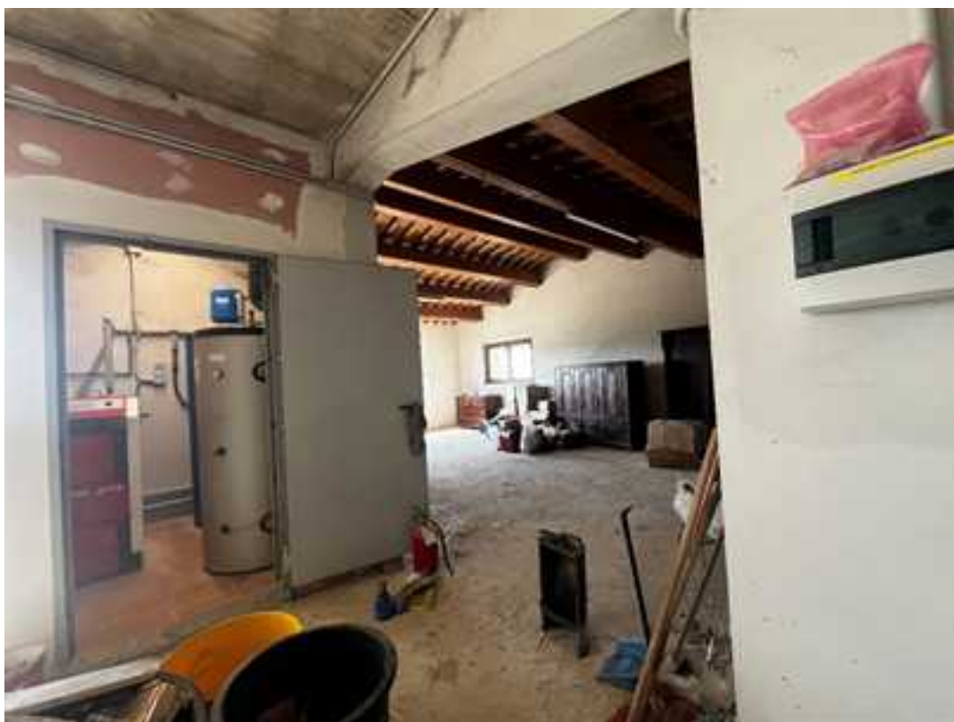
FOTO 12: VISTA VERSO NORD-OVEST DEL DEPOSITO AL DI SOTTO DELL'ABITAZIONE CENTRALE TERMICA E DEPOSITO AD UN PIANO FUORI TERRA
