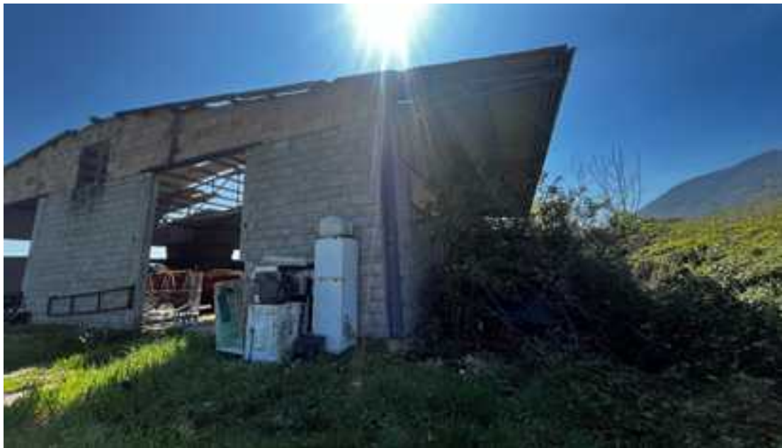
FOTO 7: VISTA DA NORD-OVEST
