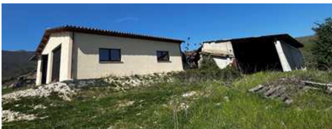
FOTO 6: VISTA DA SUD-EST
