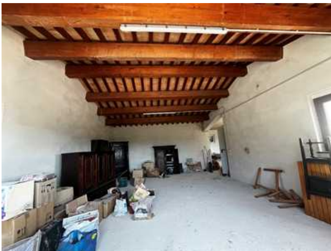
FOTO 15: PORZIONE OVEST DEL DEPOSITO AD UN PIANO FUORI TERRA-VISTA VERSO NORD
