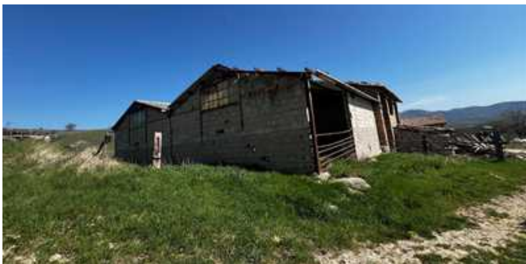
FOTO 8: VISTA SUD- OVEST
