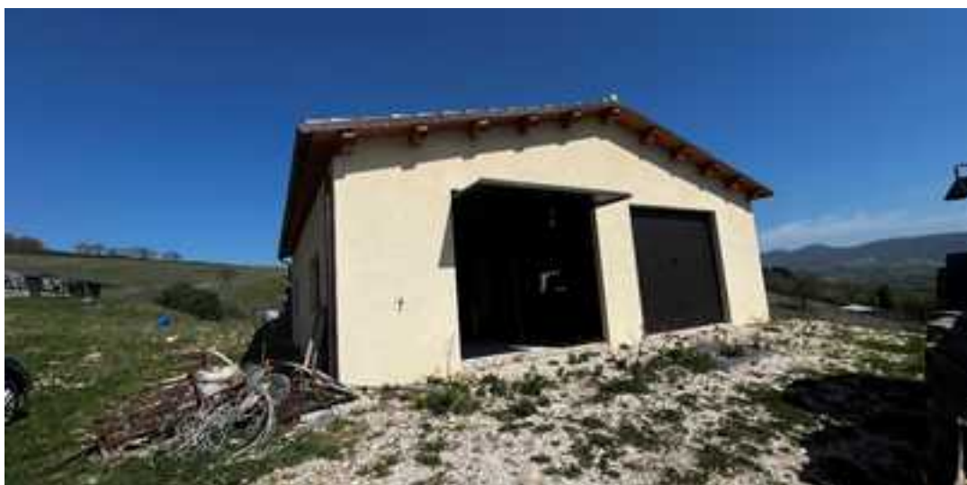
FOTO 5: VISTA PROSPETTO SUD-OVEST
