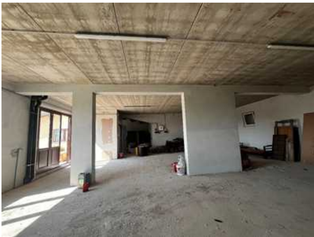
FOTO 10: VISTA VERSO OVEST DEL DEPOSITO AL DI SOTTO DELL'ABITAZIONE
