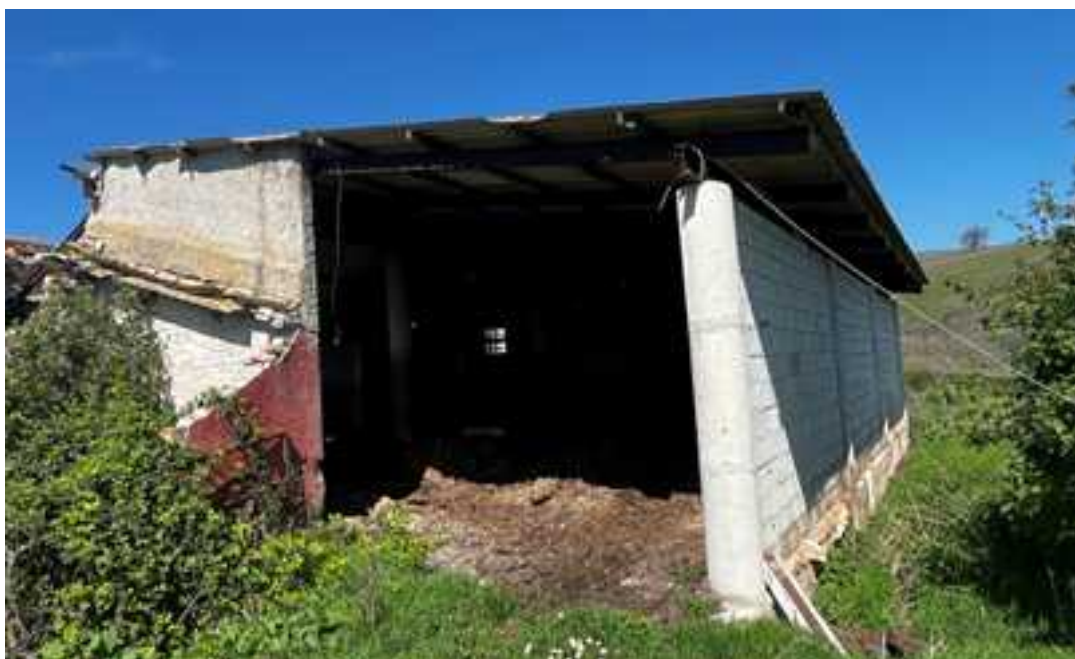
FOTO 8: VISTA PRSPETTO SUD-INGRESSO PORZIONE EST
