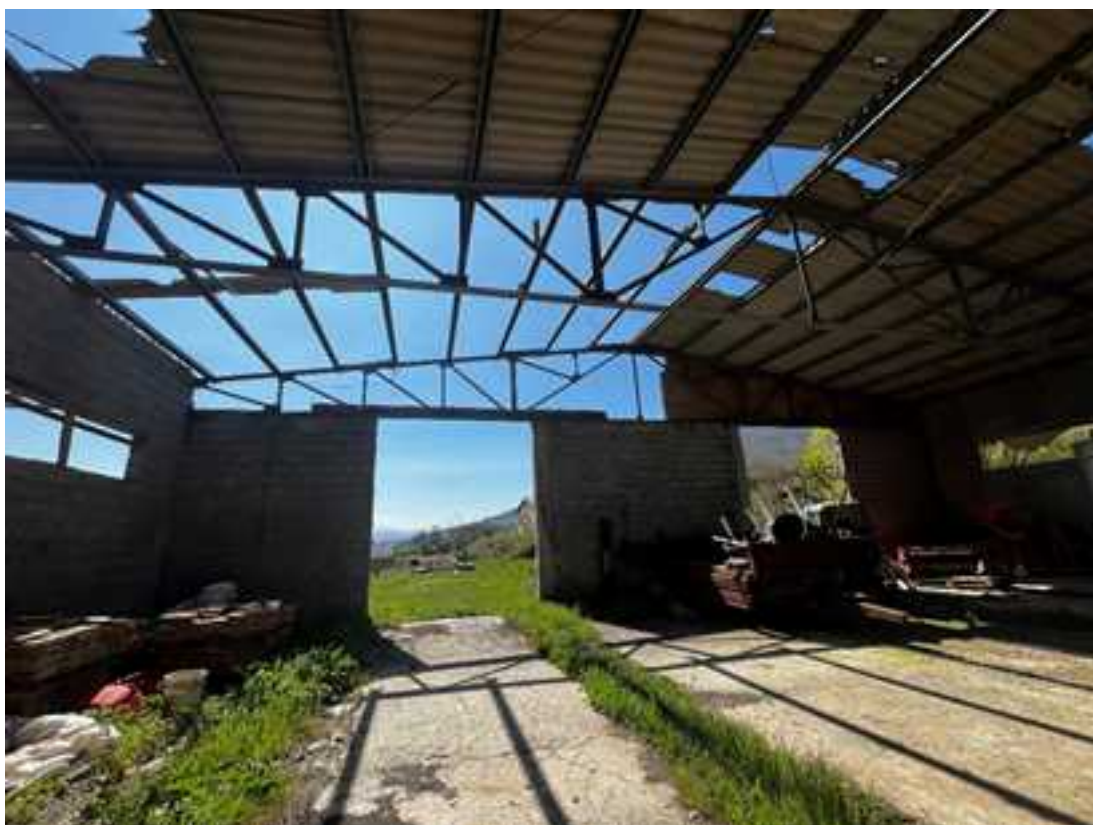
FOTO 9: PARTICOLARE VISTA INTERNA VERSO SUD
