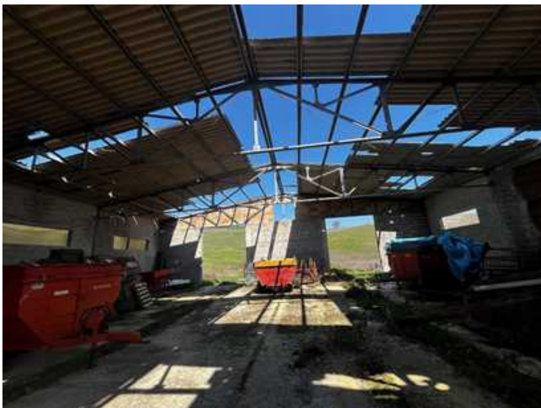
FOTO 10: VISTA INTERNA VERSO NORD
