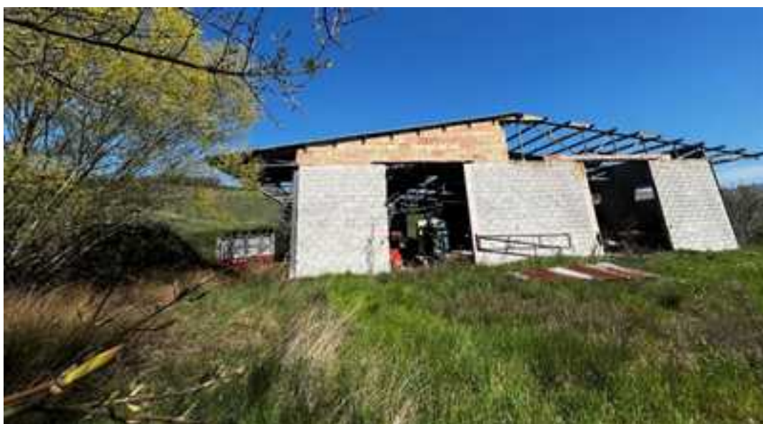
FOTO 3: VISTA DA SUD
