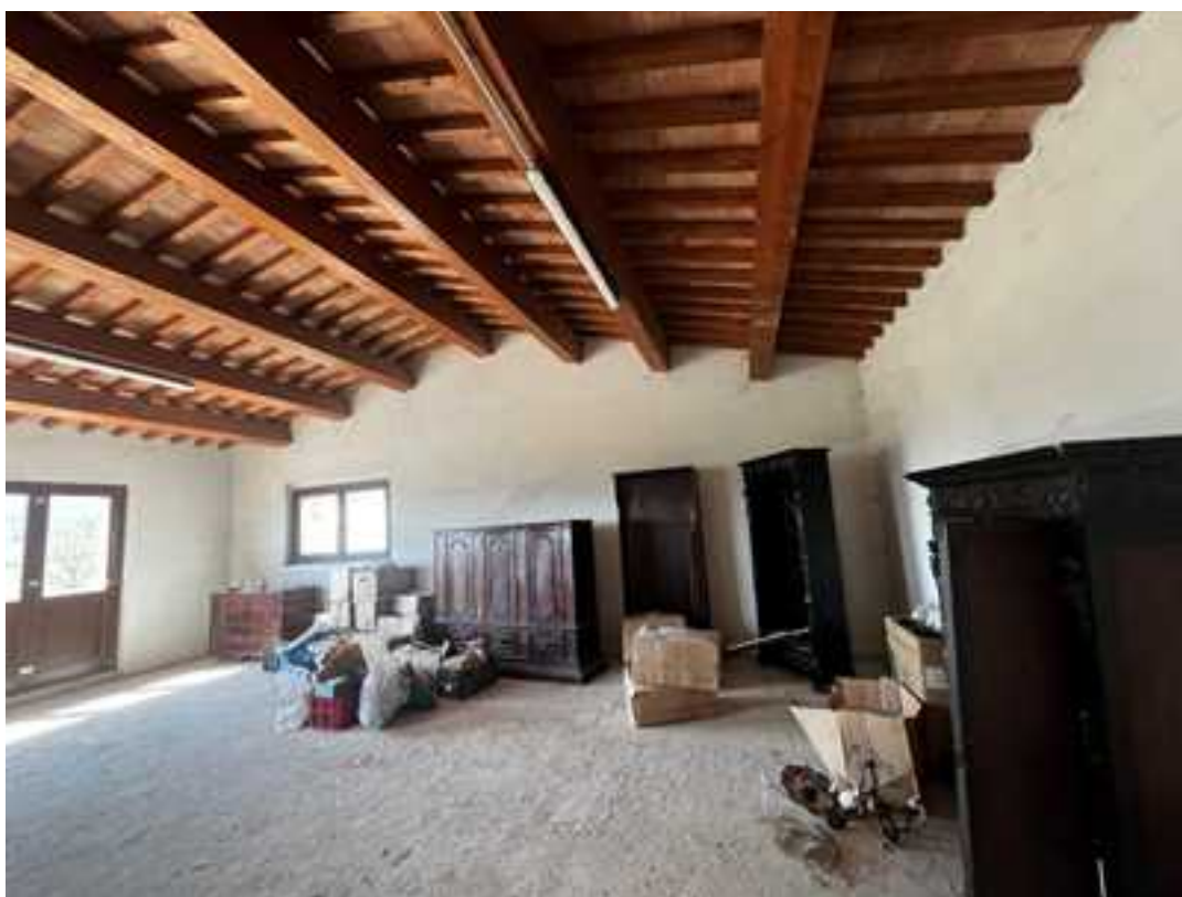
FOTO 13: PORZIONE OVEST DEL DEPOSITO AD UN PIANO FUORI TERRA
