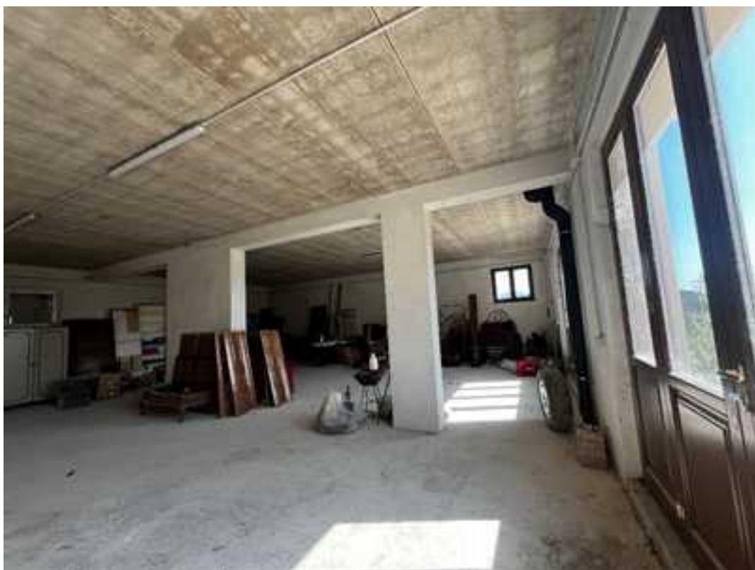
FOTO 8: VISTA VERSO EST DEL DEPOSITO AL DI SOTTO DELL'ABITAZIONE
