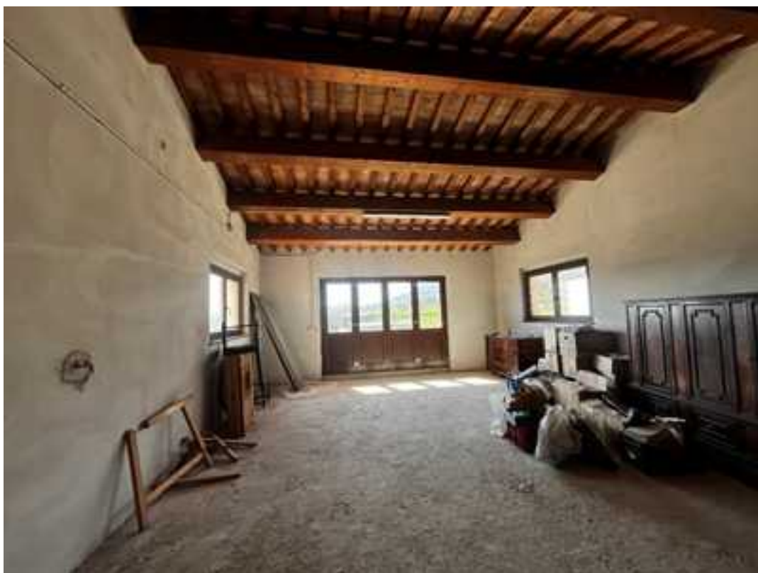
FOTO 14: PORZIONE OVEST DEL DEPOSITO AD UN PIANO FUORI TERRA-VISTA VERSO SUD
