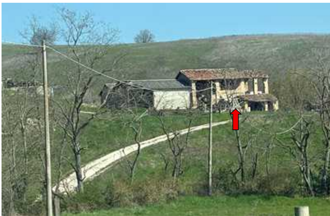
FOTO 2: PARTICOLARE IMMOBILE DALLA STRADA DI ACCESSO
