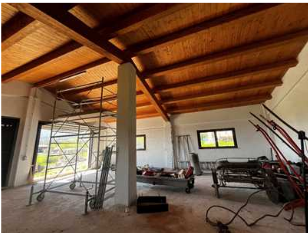
FOTO 10: VISTA INTERNA VERSO OVEST
