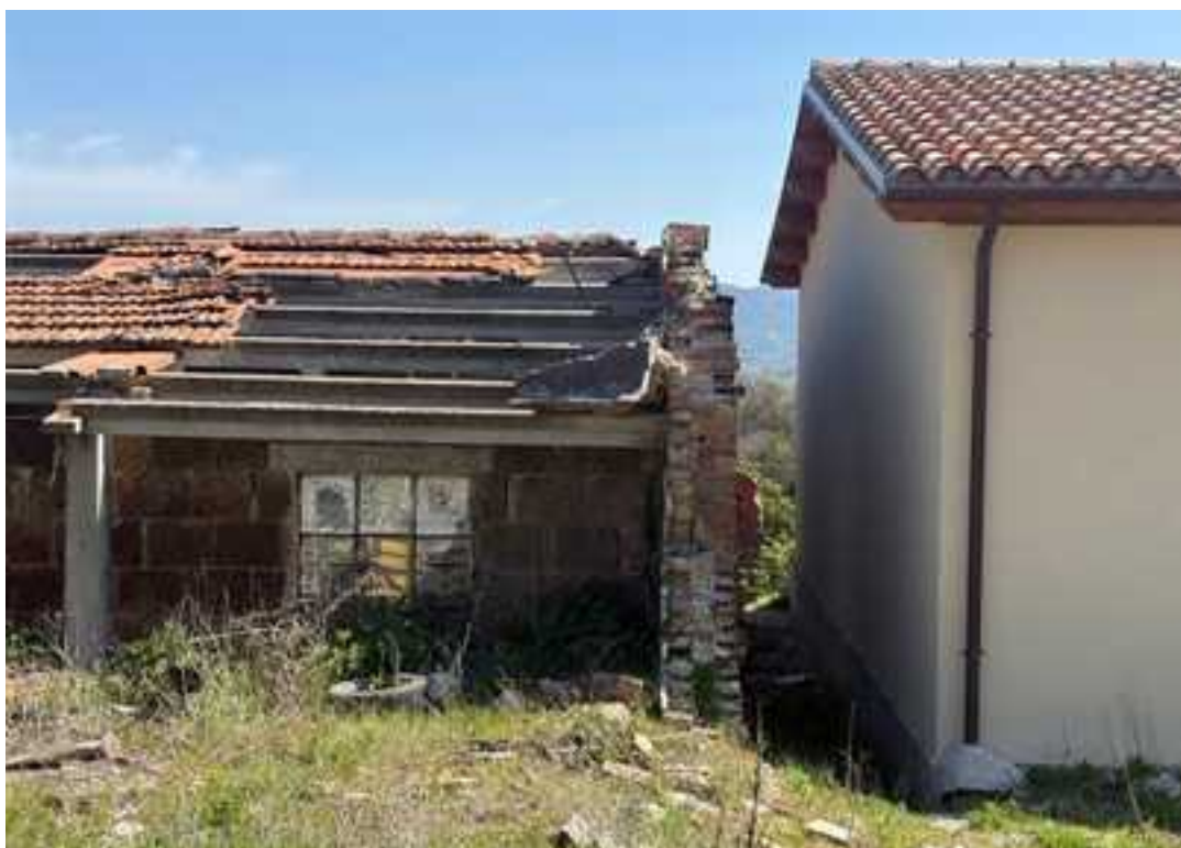
FOTO 4: VISTA PROSPETTO NORD
