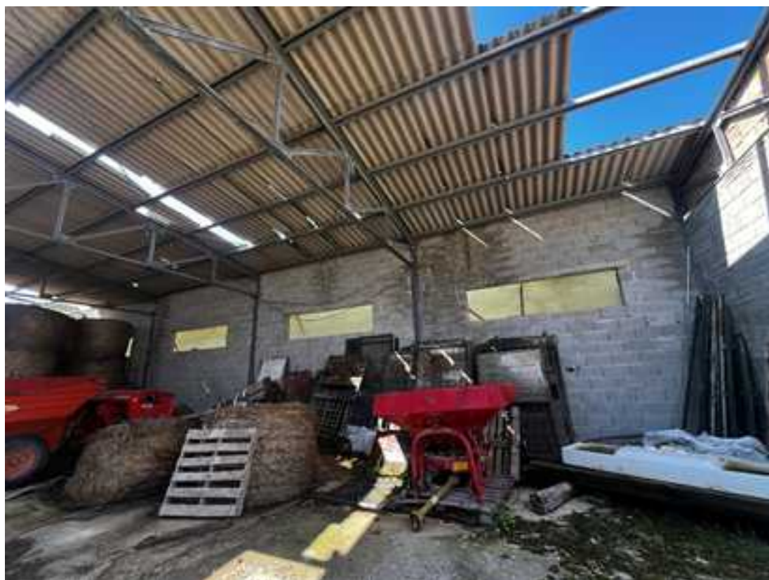
FOTO 11: VISTA INTERNA VERSO OVEST
