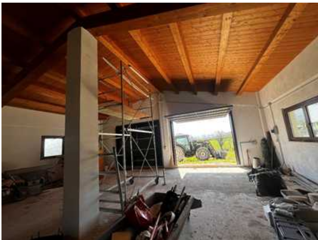
FOTO 8: VISTA INTERNA VERSO L'INGRESSO
