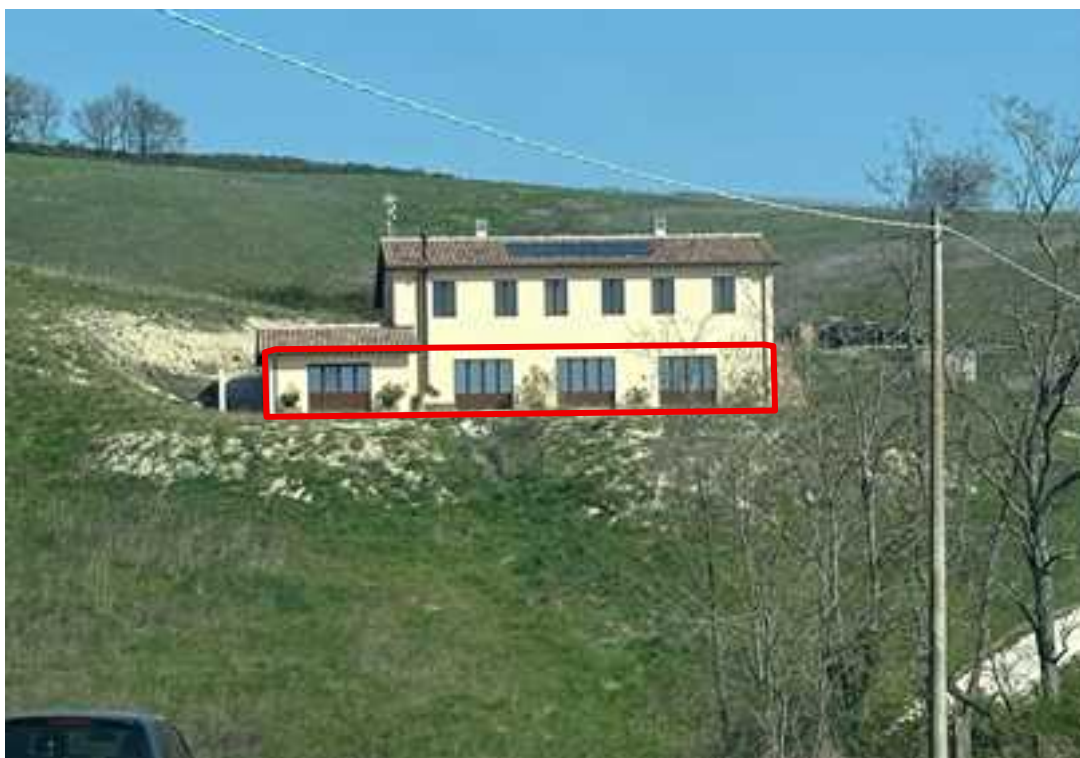
FOTO 2: VISTA DA SUD
