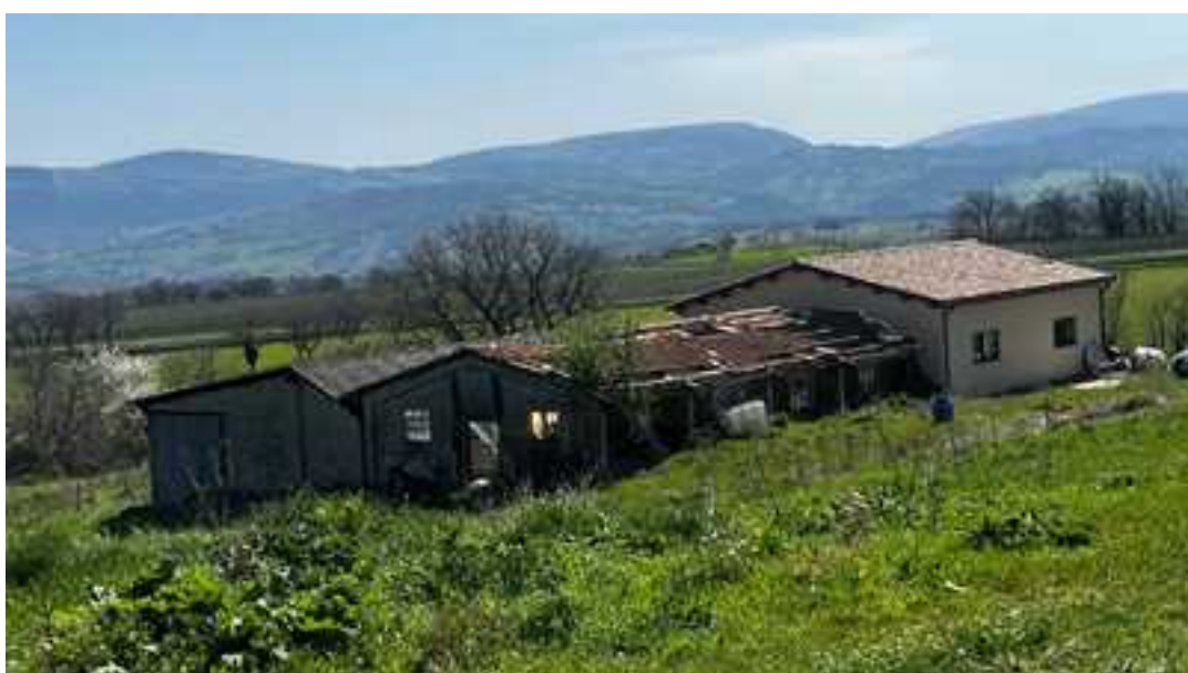
FOTO 3: VISTA DA NORD-OVEST
