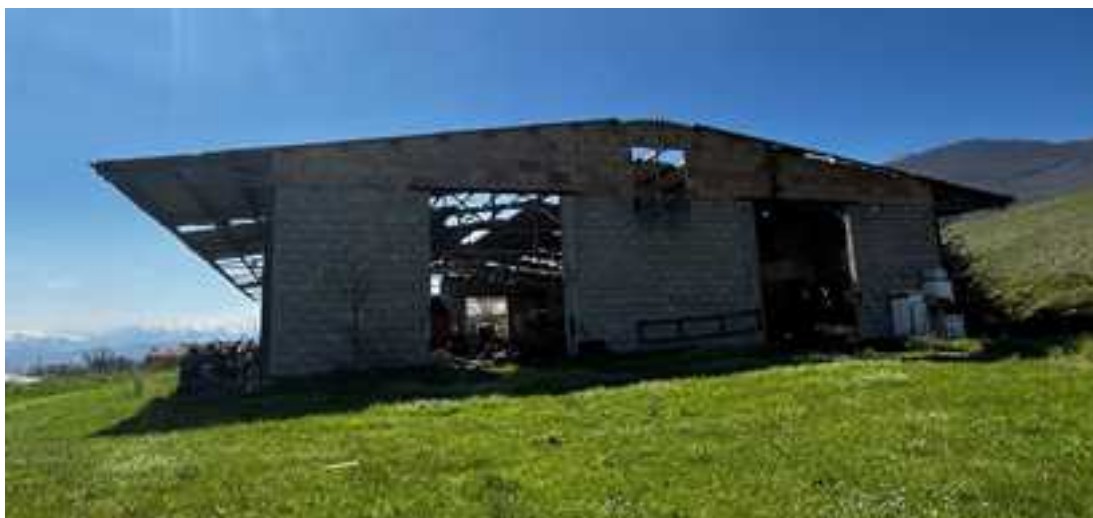
FOTO 6: VISTA DA NORD
