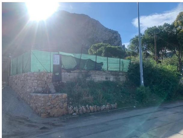
FOTO 01: Muro che impedisce l'accesso diretto da strada
