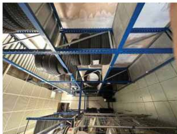
ID 0295: Scaffalatura inox blu Modulblock dimensioni 1000x60x362; ID 0295: Scaffalatura inox blu Modulblock dimensioni 475x60x362
