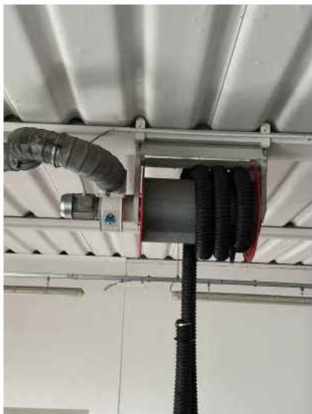
ID 0262 Aspiratore gas di scarico con raccoglitore
