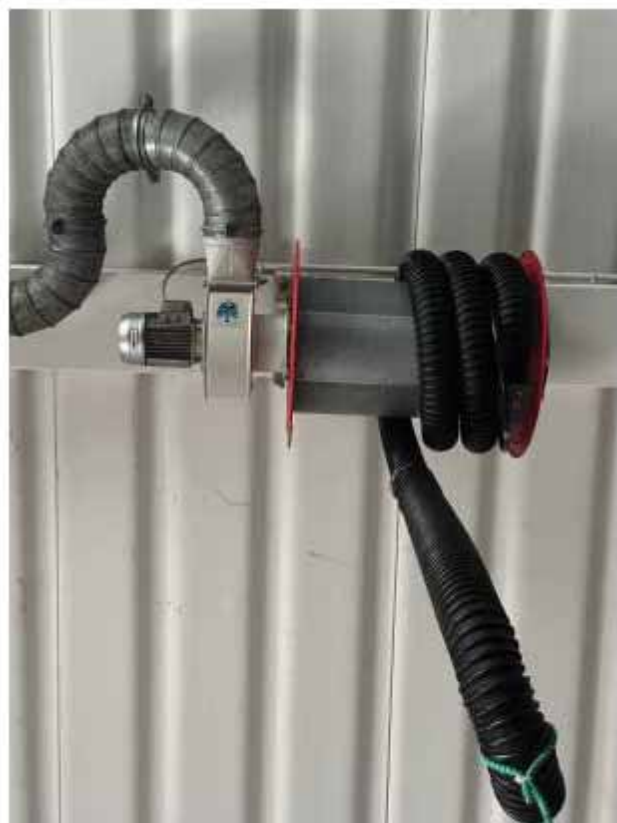
ID 0262 Aspiratore gas di scarico con raccoglitore
