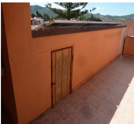
Foto 28 – Apertura vano tecnico
