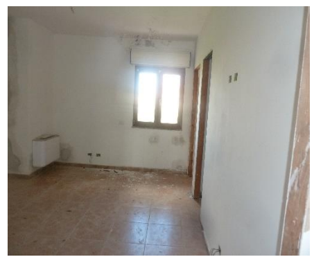
Foto n. 15 Vano letto 1 con bagno
