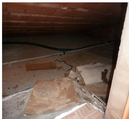
Foto 29 – Interno vano Tecnico
