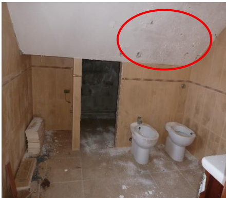
Foto 7 – servizio igienico ingresso
