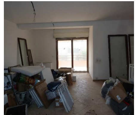
Foto 9 – soggiorno con veduta su balcone
