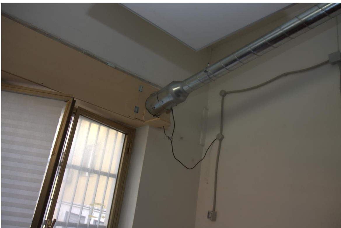
Foto n. 12: Lotto 1, Pescara, foglio n° 25 particella n° 129, sub 112, particolare interno del fabbricato.
