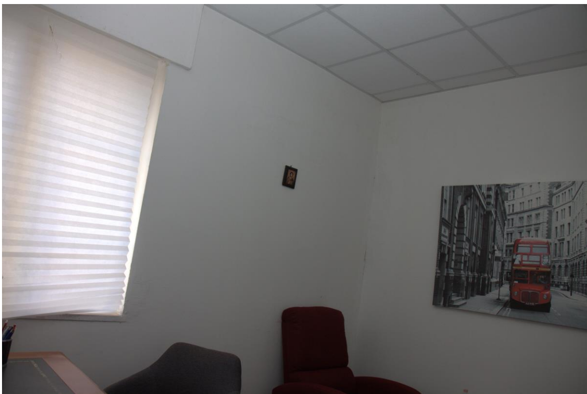
Foto n. 13: Lotto 1, Pescara, foglio n° 25 particella n° 129, sub 112, particolare interno del fabbricato.
