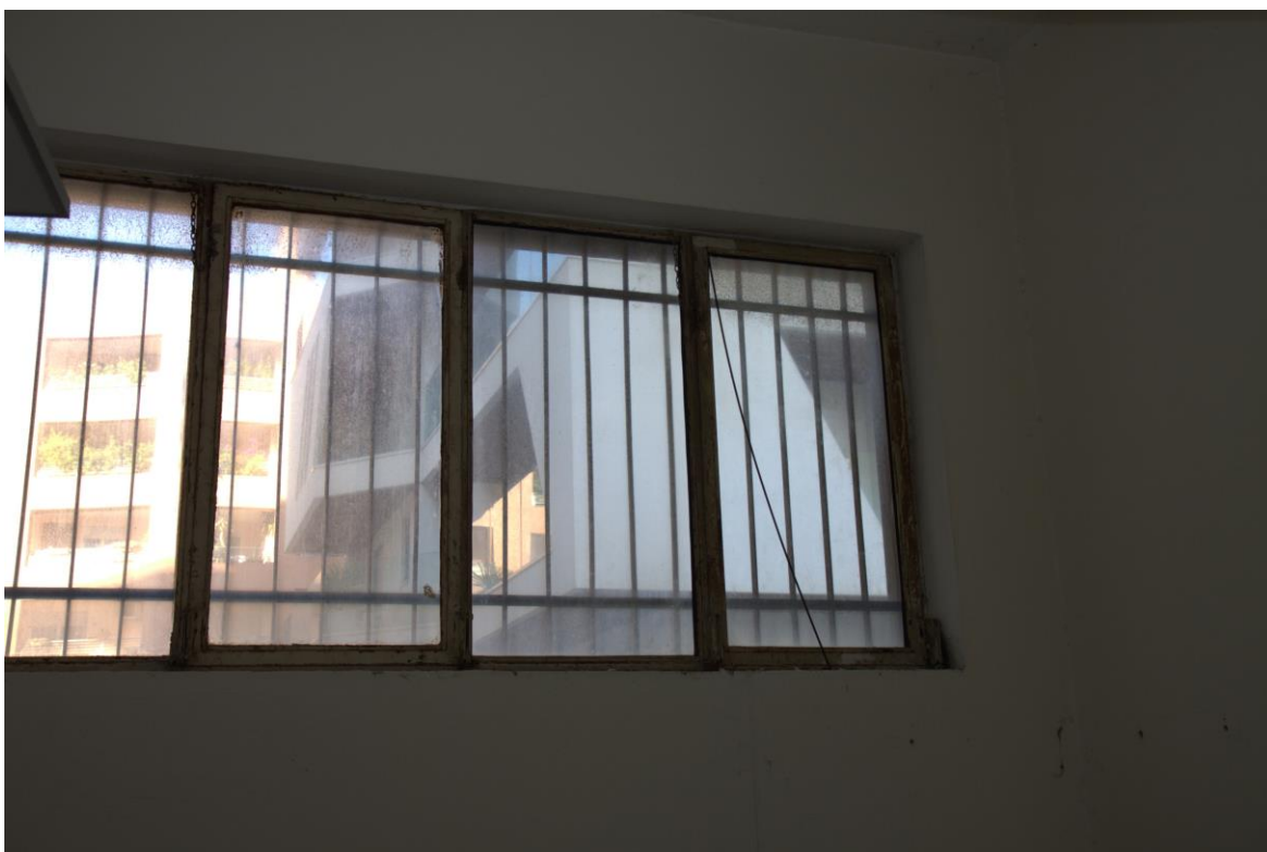
Foto n. 8: Lotto 1, Pescara, foglio n° 25 particella n° 129, sub 112, particolare interno del fabbricato.
