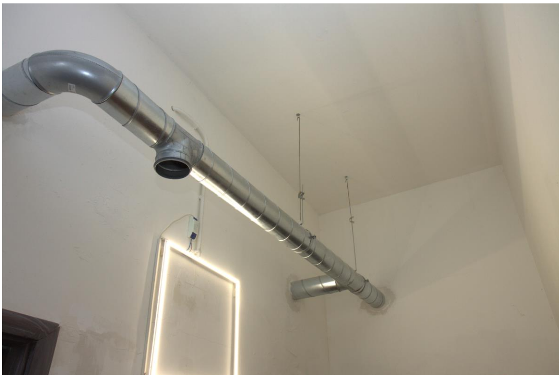
Foto n. 7: Lotto 1, Pescara, foglio n° 25 particella n° 129, sub 112, particolare interno del fabbricato.
