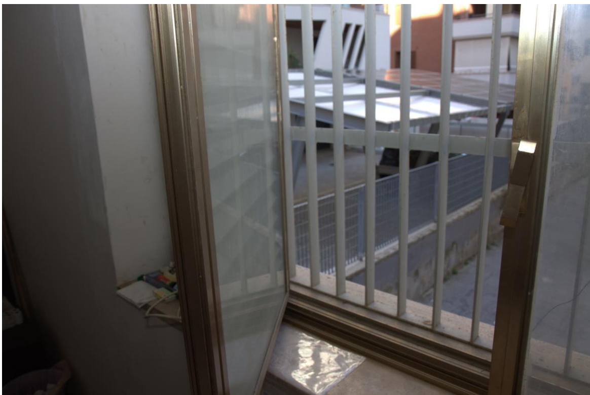
Foto n. 9: Lotto 1, Pescara, foglio n° 25 particella n° 129, sub 112, particolare interno del fabbricato.
