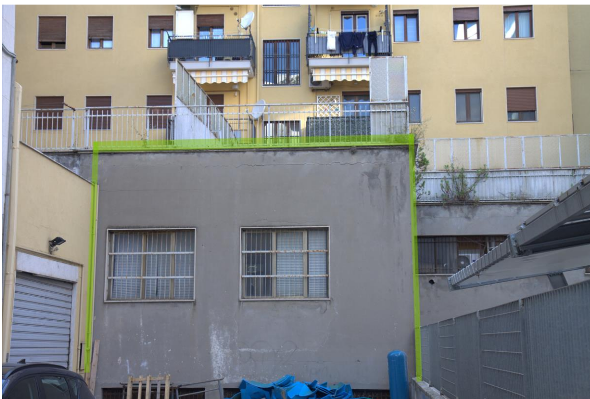
Foto n. 2: Lotto 1, Pescara, foglio n° 25 particella n° 129 sub 112, particolare esterno del fabbricato oggetto d'esecuzione.
