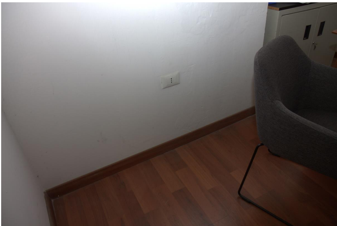
Foto n. 11: Lotto 1, Pescara, foglio n° 25 particella n° 129, sub 112, particolare interno del fabbricato.
