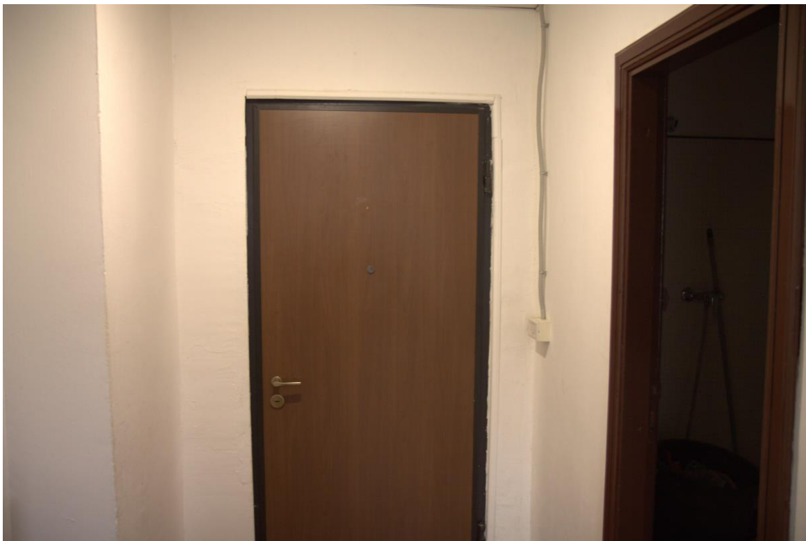
Foto n. 4: Lotto 1, Pescara, foglio n° 25 particella n° 129 sub 112, particolare interno dell'ingresso.
