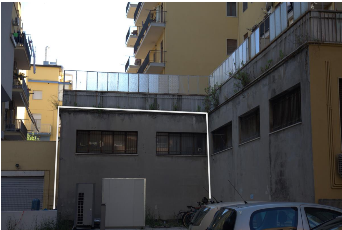
Foto n. 3: Lotto 1, Pescara, foglio n° 25 particella n° 129 sub 112, particolare esterno del fabbricato oggetto d'esecuzione.
