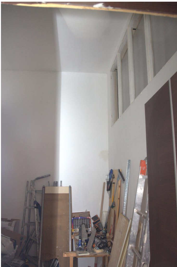
Foto n. 17: Lotto 1, Pescara, foglio n° 25 particella n° 129, sub 112, particolare interno dell'ufficio.
