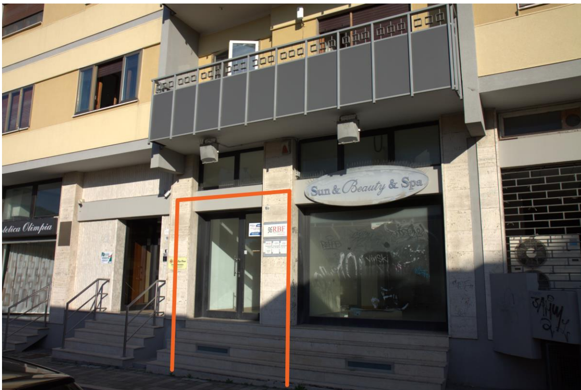
Foto n. 1: Lotto unico, Pescara, foglio n° 25 particella n° 129, particolare esterno dell'ingresso al sub 114 (parte comune).
