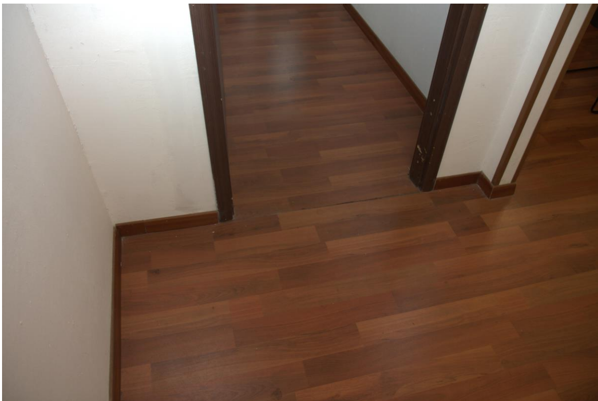
Foto n. 6: Lotto 1, Pescara, foglio n° 25 particella n° 129, sub 112, particolare interno del fabbricato.
