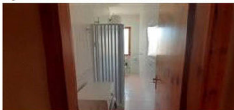
Veduta interna: servizio igienico
