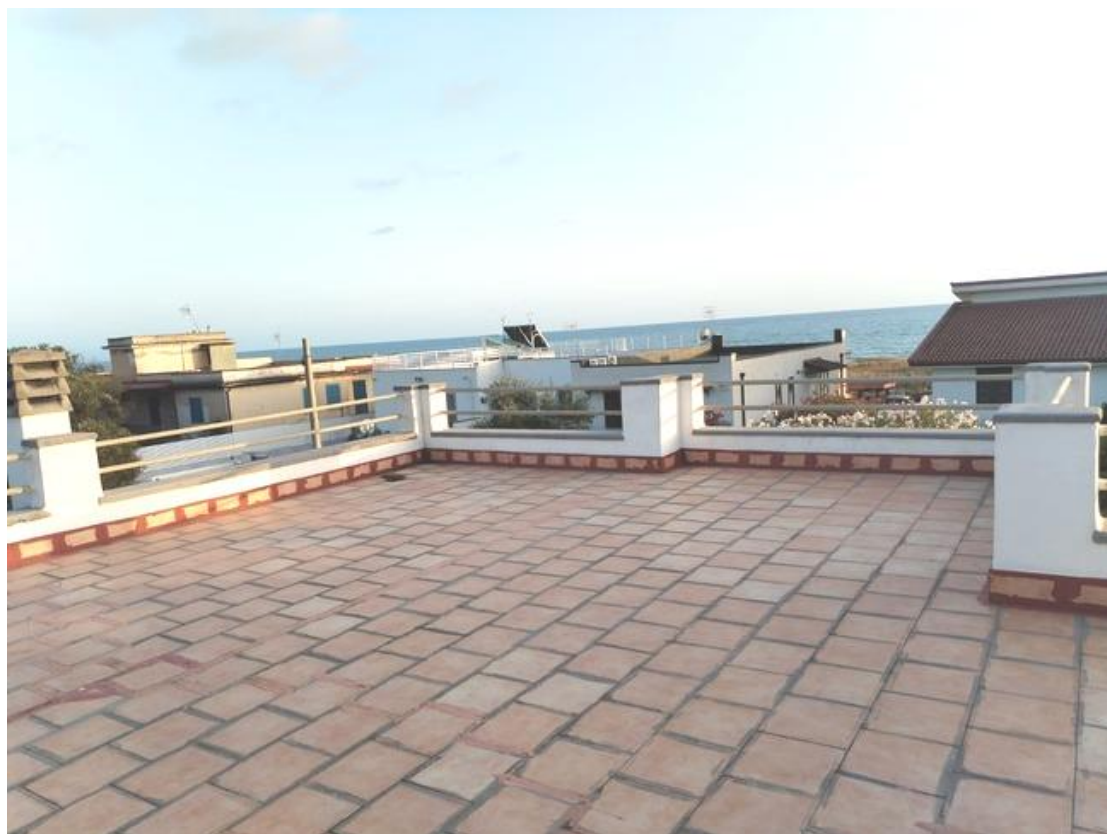
Foto n°13 - Vista lastrico solare
