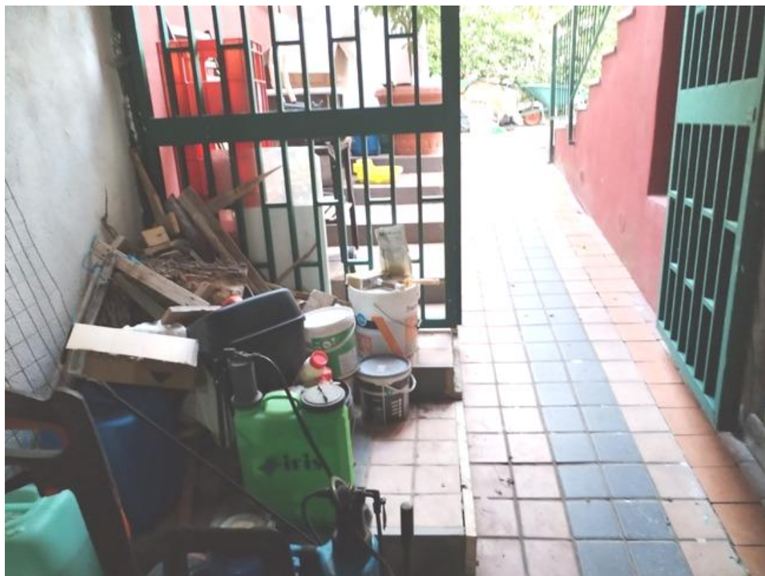
Foto n°11 – Vista rampa di accesso al piano seminterrato
