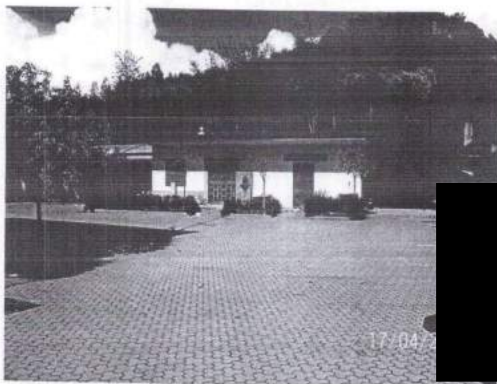
Foto 1. Locale magazzino e deposito
