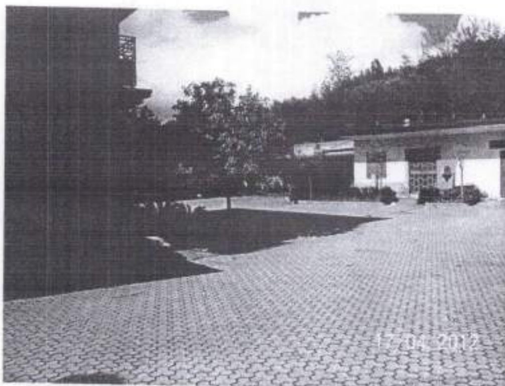
Foto 2. Locale magazzino e deposito
