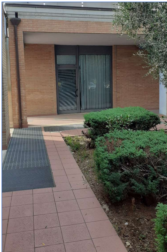
Foto n.1- Accesso al Compendio immobiliare
