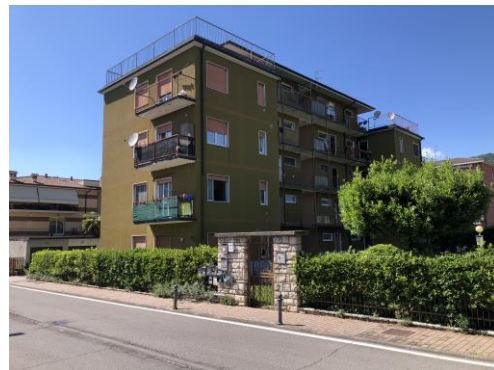
Edificio lato sud/est
