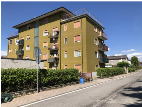
Edificio lato ovest
