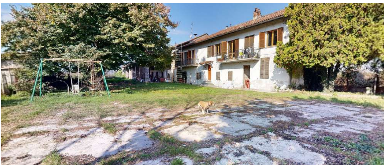
6. Vista d'insieme dei beni oggetto di stima: unità abitativa (Sub. 5), tettoia (Sub. 3), cortile comune (Sub. 1) e basso fabbricato (Sub. 5).
