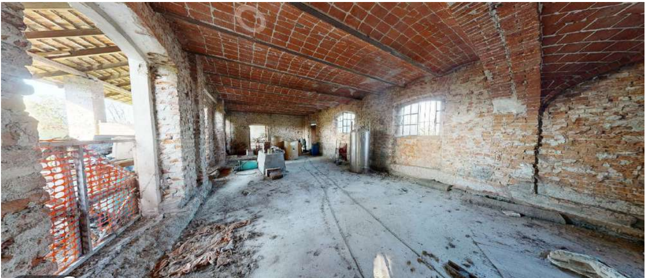
35. Deposito 1 (sub. 5-piano terra).
