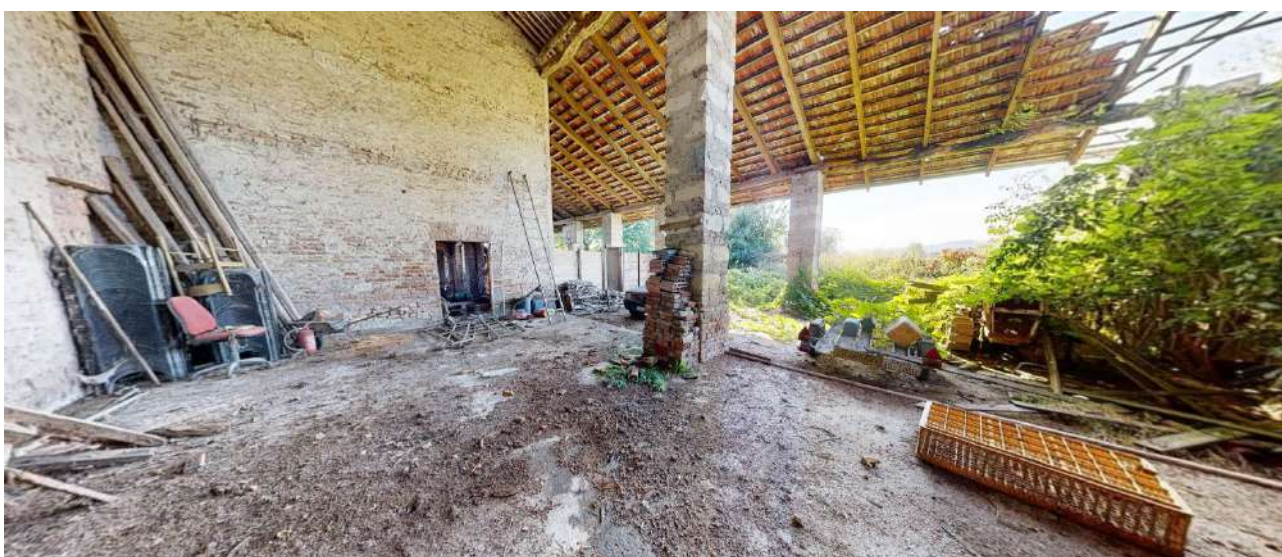
39. Vista della tettoia (sub. 3-piano terra).
