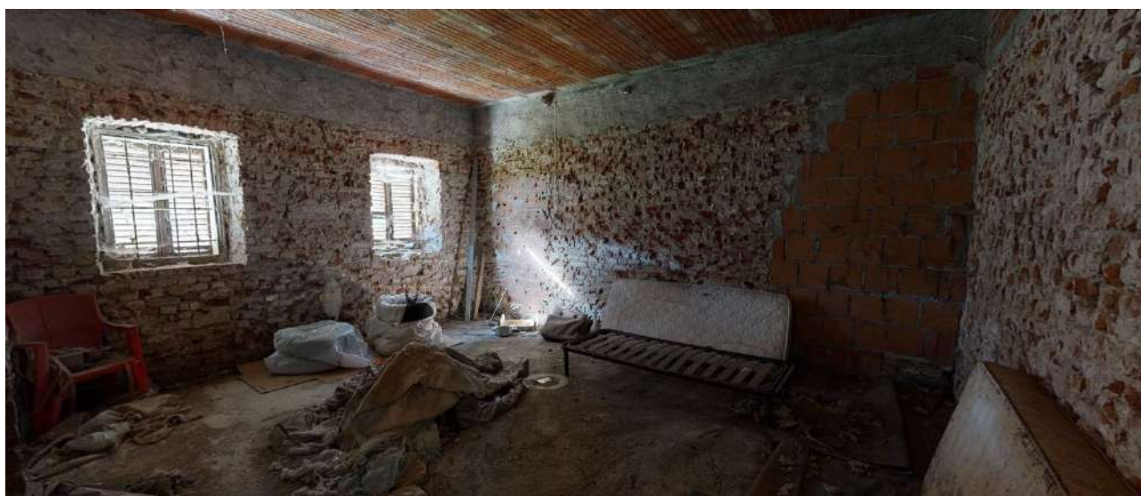
26. Locale di sgombero al rustico 2 (sub. 5-piano terra).
