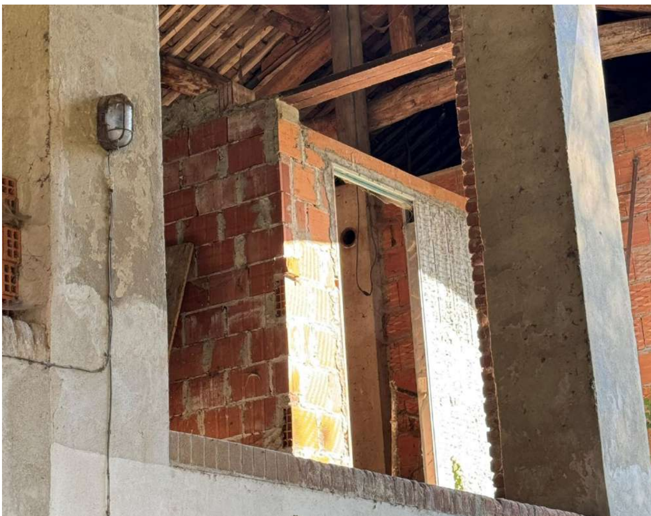
46. Ex-fienile con locale sgombero al rustico (sub. 3-piano primo).
