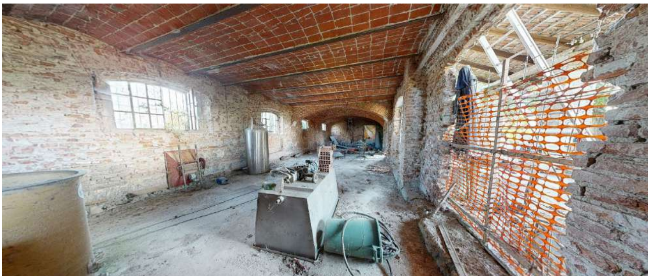
37. Deposito 1 (sub. 5-piano terra).
