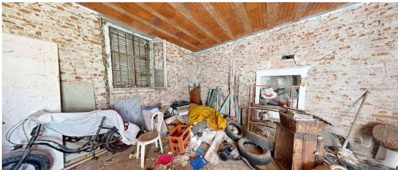
25. Locale di sgombero al rustico 1 (sub. 5-piano terra).
