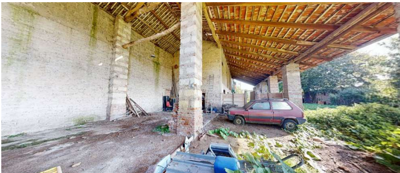
40. Vista della tettoia (sub. 3-piano terra).
