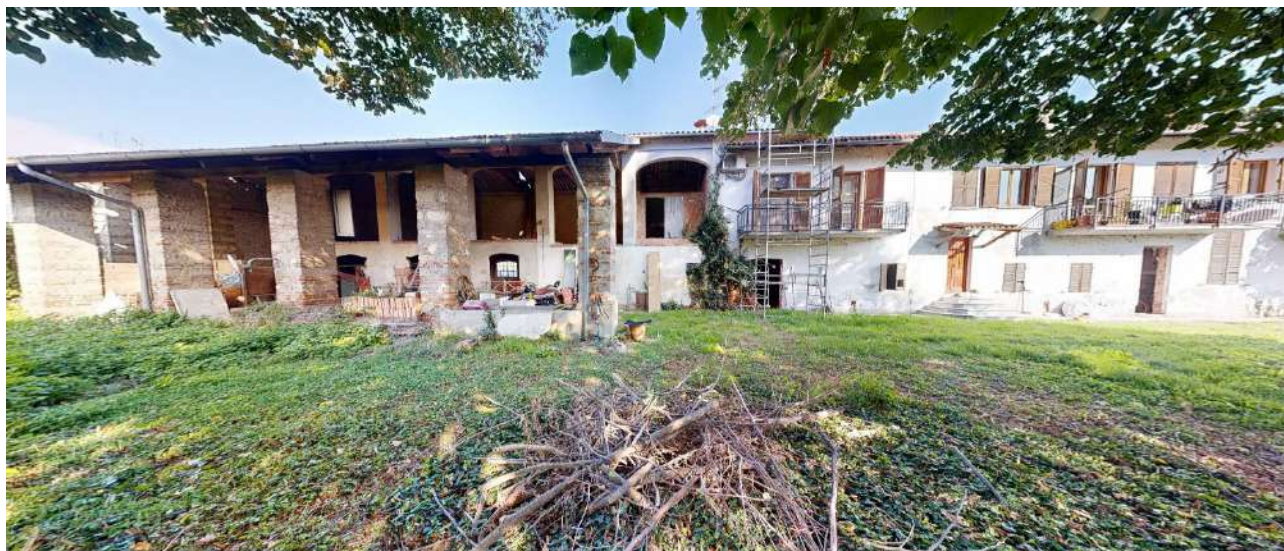
7. Vista d'insieme dei beni oggetto di stima: unità abitativa (Sub. 5), tettoia (Sub. 3), cortile comune (Sub. 1).
