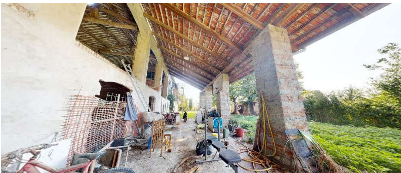
42. Vista della tettoia (sub. 3-piano terra).
