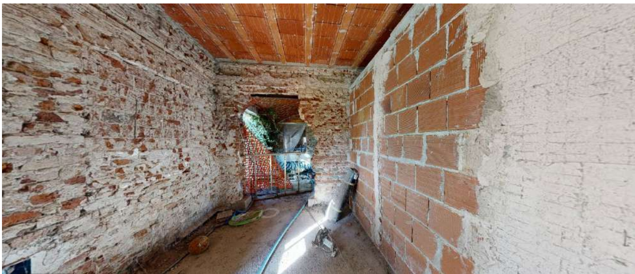
29. Locale di sgombero al rustico 4 (sub. 5-piano terra).
