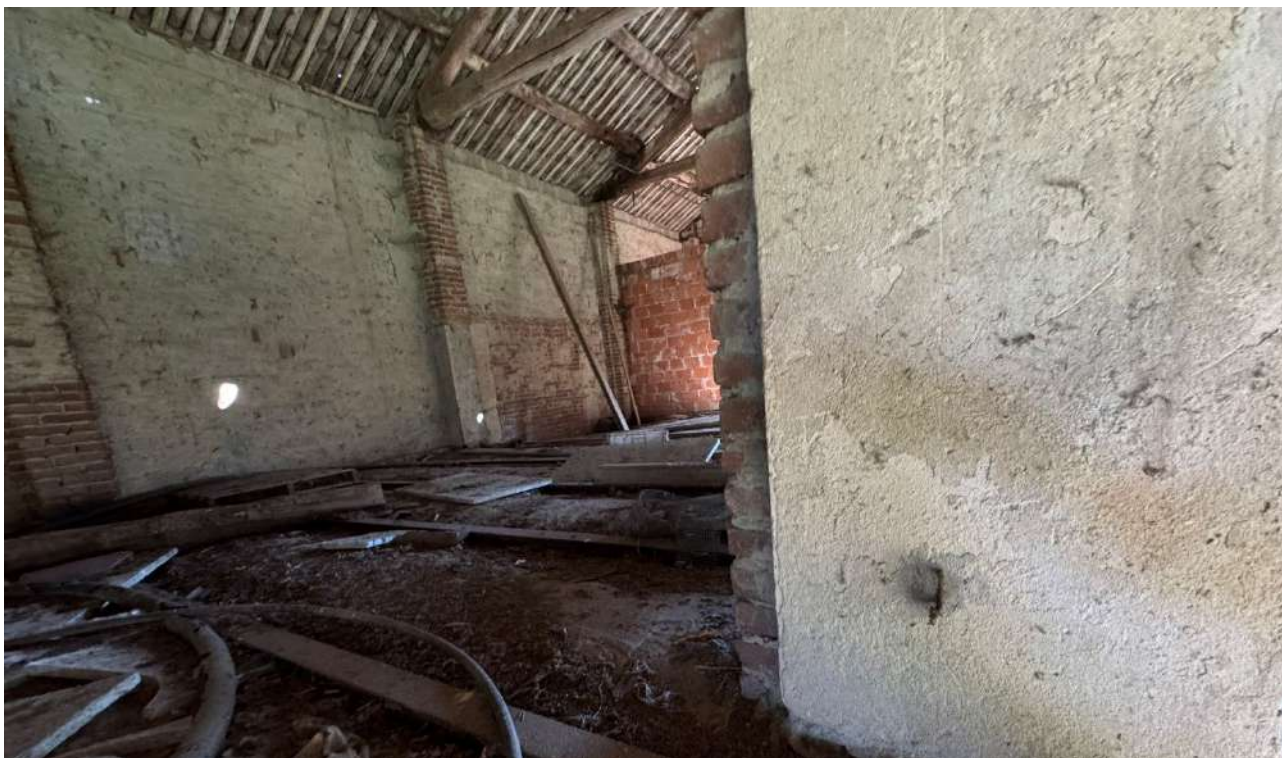
45. Ex-fienile (sub. 3-piano primo).
