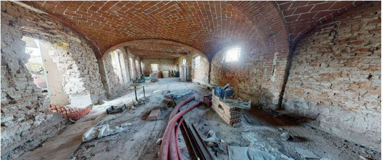
34. Deposito 1 (sub. 5-piano terra).
