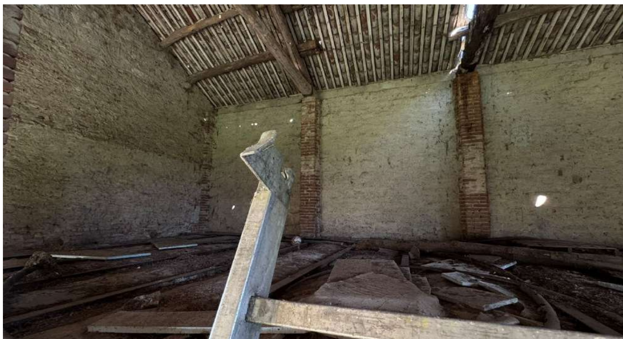
44. Ex-fienile (sub. 3-piano primo).
