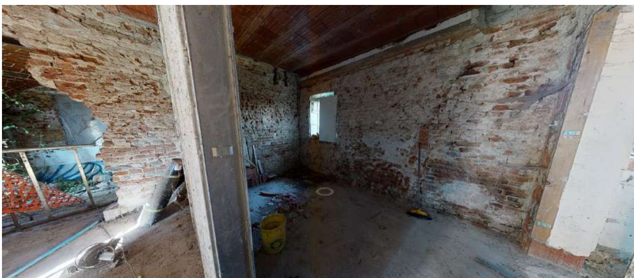
30. Locale di sgombero al rustico 3 (sub. 5-piano terra).
