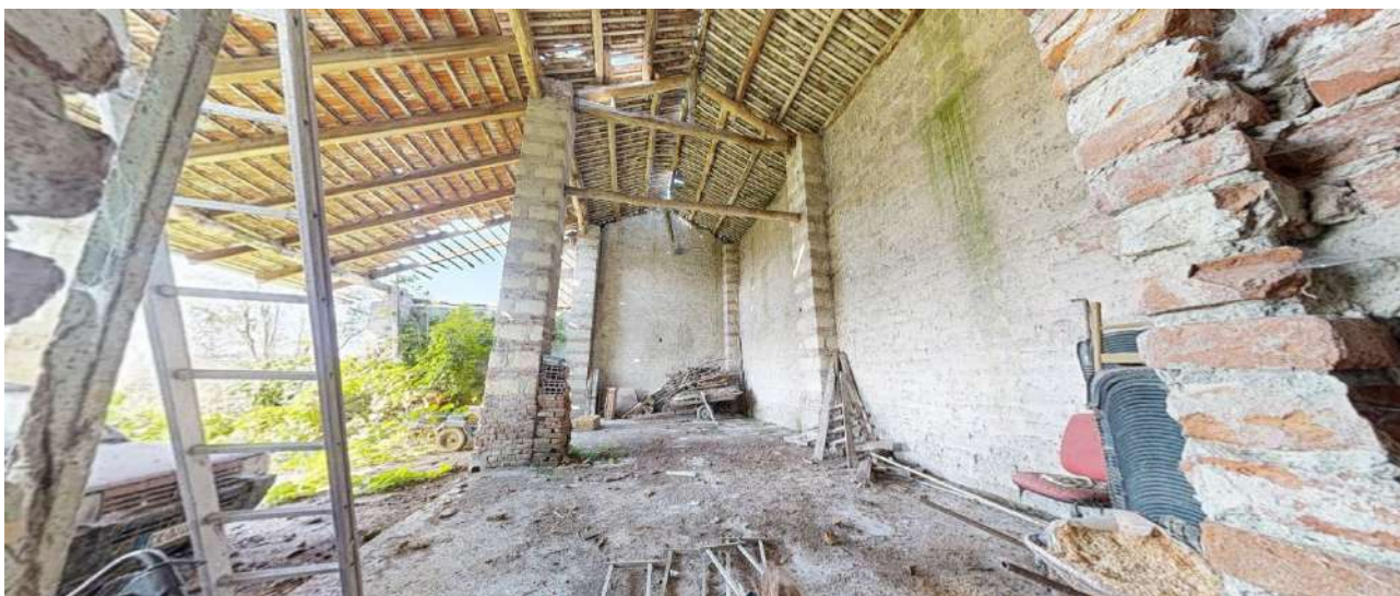
38. Vista della tettoia (sub. 3-piano terra).
