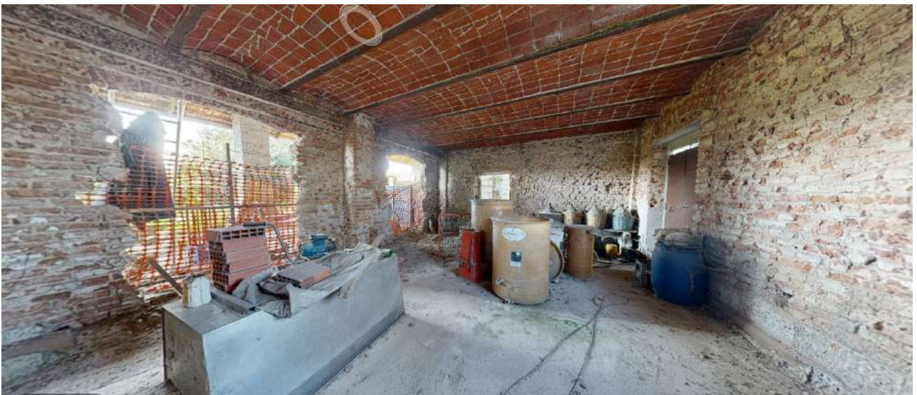
36. Deposito 1 (sub. 5-piano terra).
