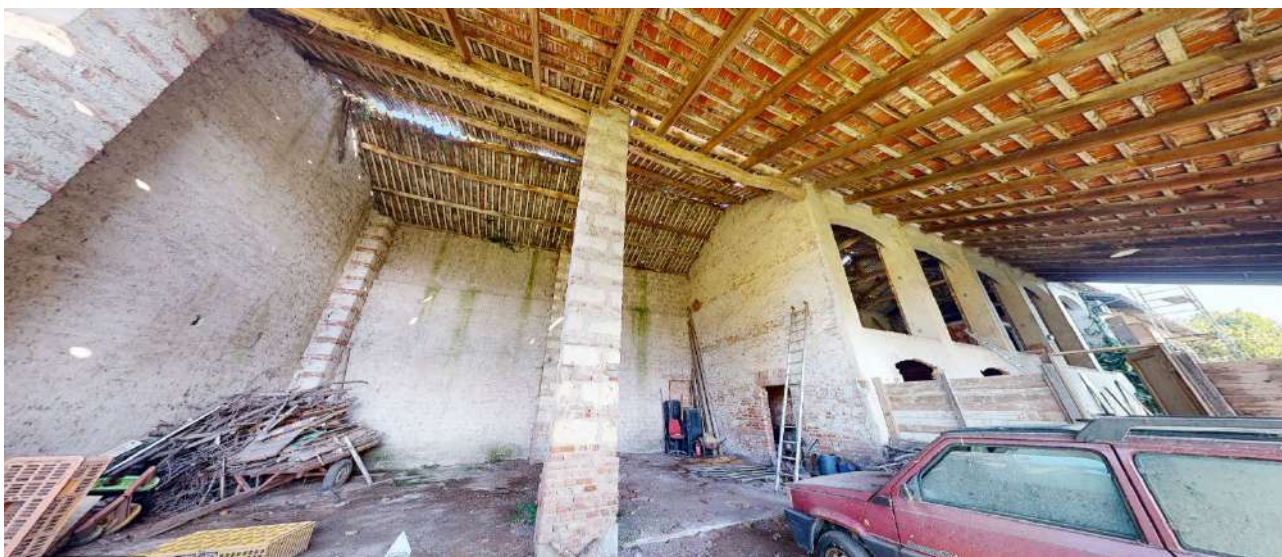
41. Vista della tettoia (sub. 3-piano terra).
