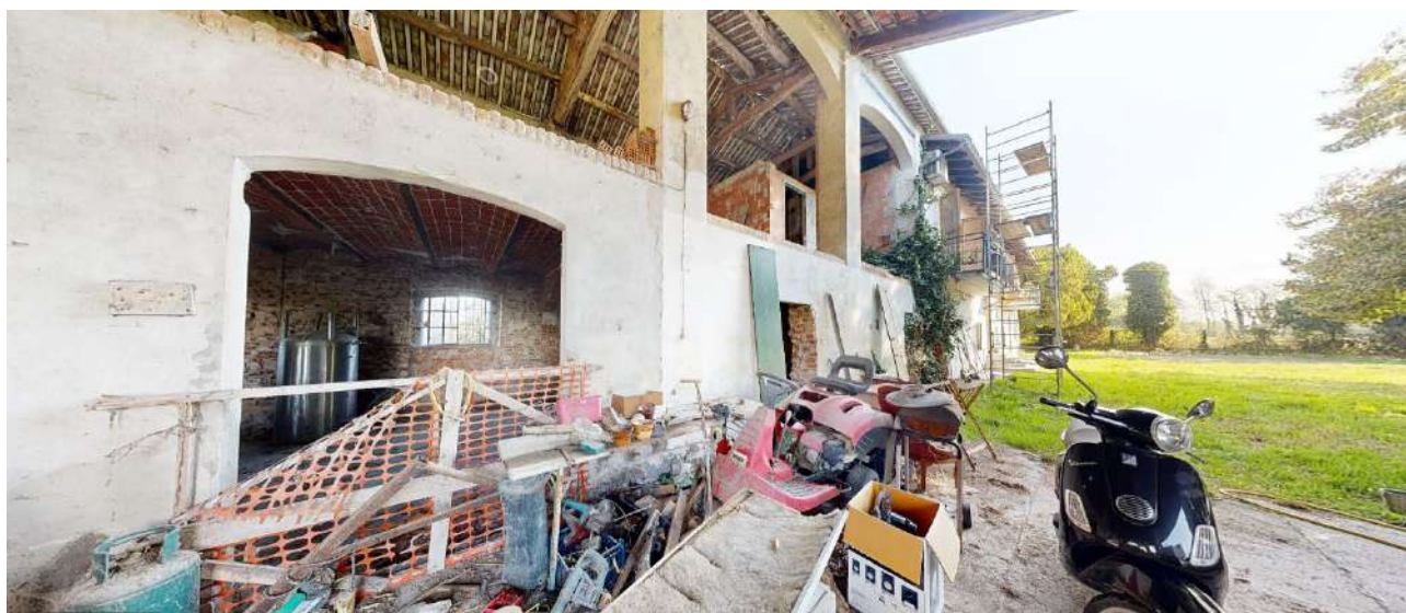
43. Vista della tettoia (sub. 3-piano terra).
