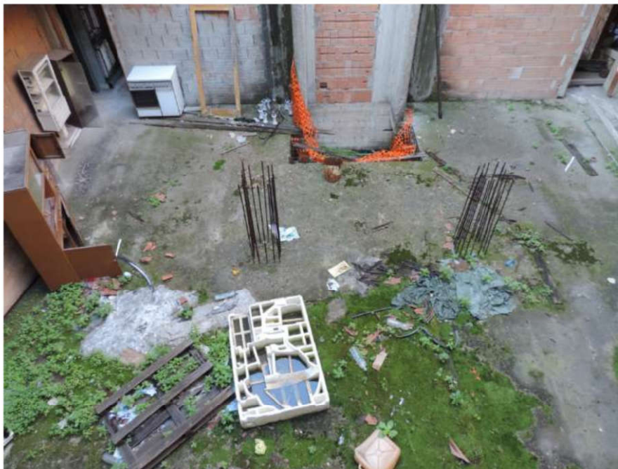
Corte interna : vista del vano ascensore
