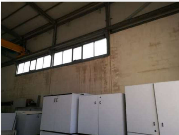
Parete magazzino lato ovest
