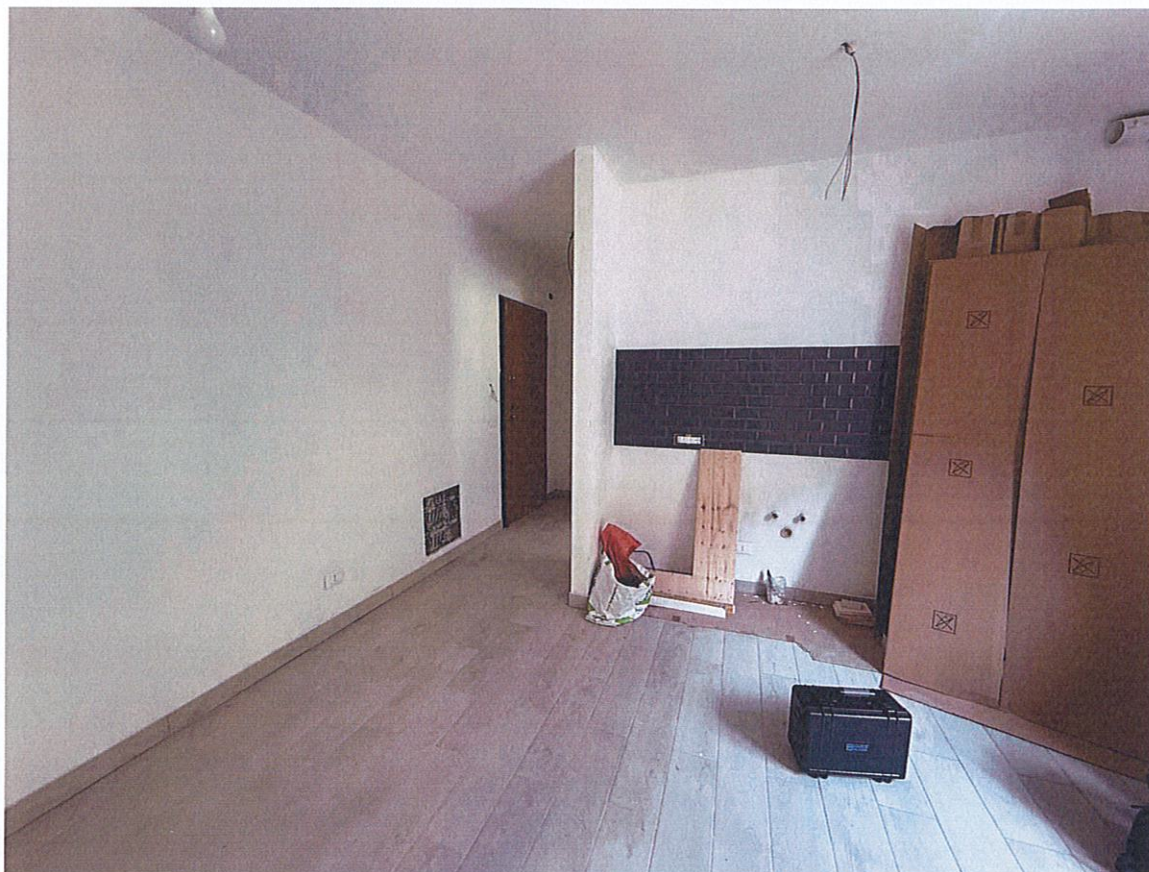
Figura 7 – Soggiorno PT verso ingresso
