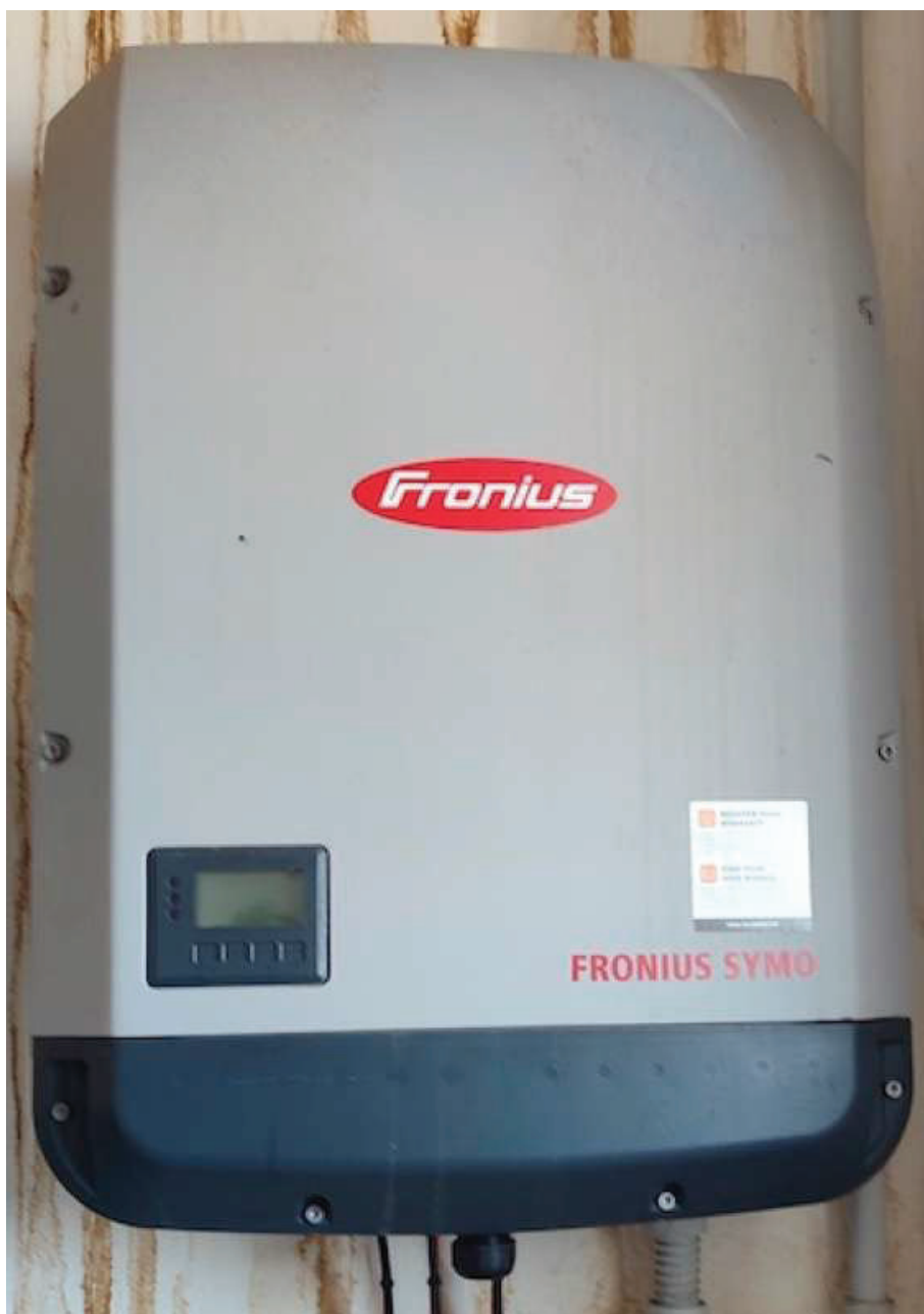
Foto 11 – Inverter per impianto fotovoltaico di 15 kW
