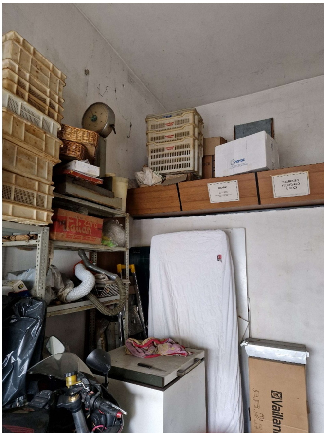
Vista della controparte lignea di fondo e impalcato accessibile con scala a pioli
