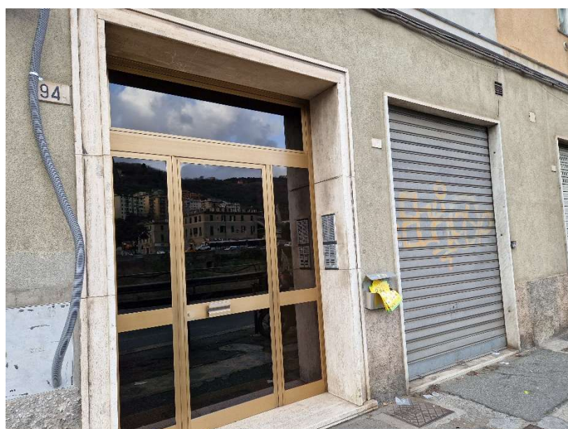
Portone dell'immobile e adiacente serranda del negozio oggetto di pignoramento
