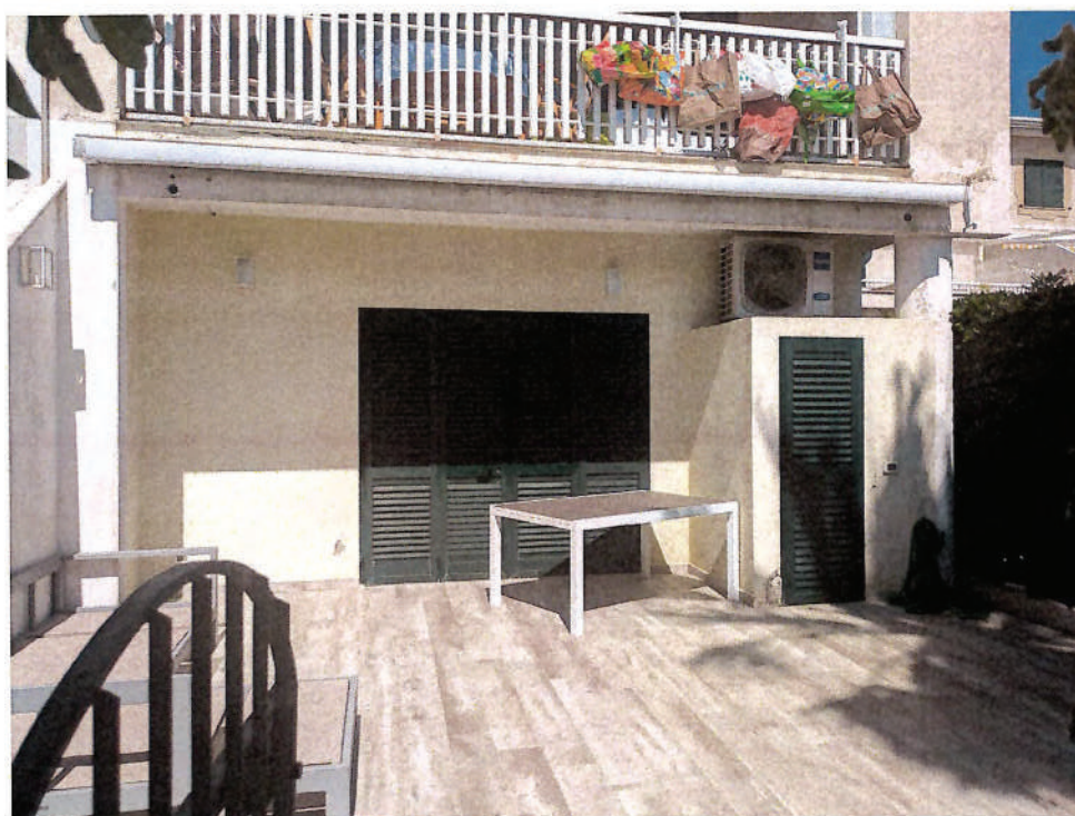
Foto n° 10 - Vista Cortile Privato Esterno
