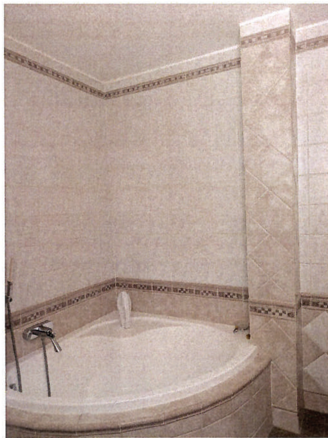
Foto n° 13- Vista Bagno Piano Terra
