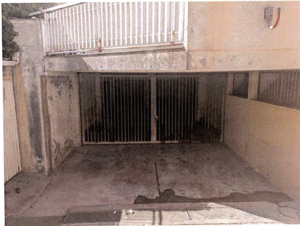
Foto n° 1 - Vista Ingresso Comune Cantinola
