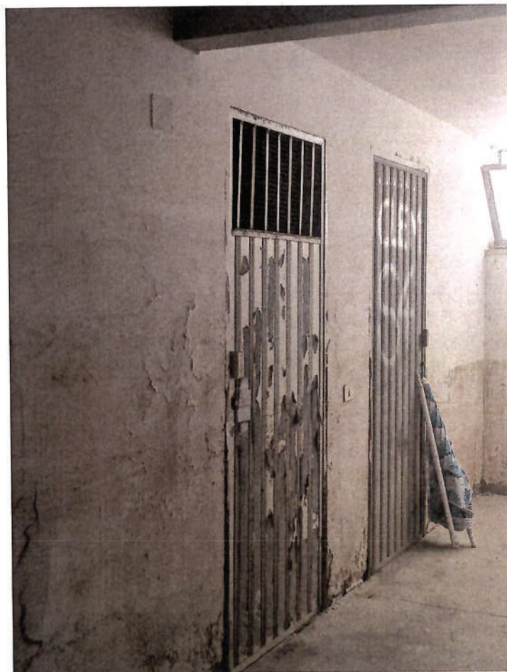
Foto n° 2 - Vista Esterna Cantinola
