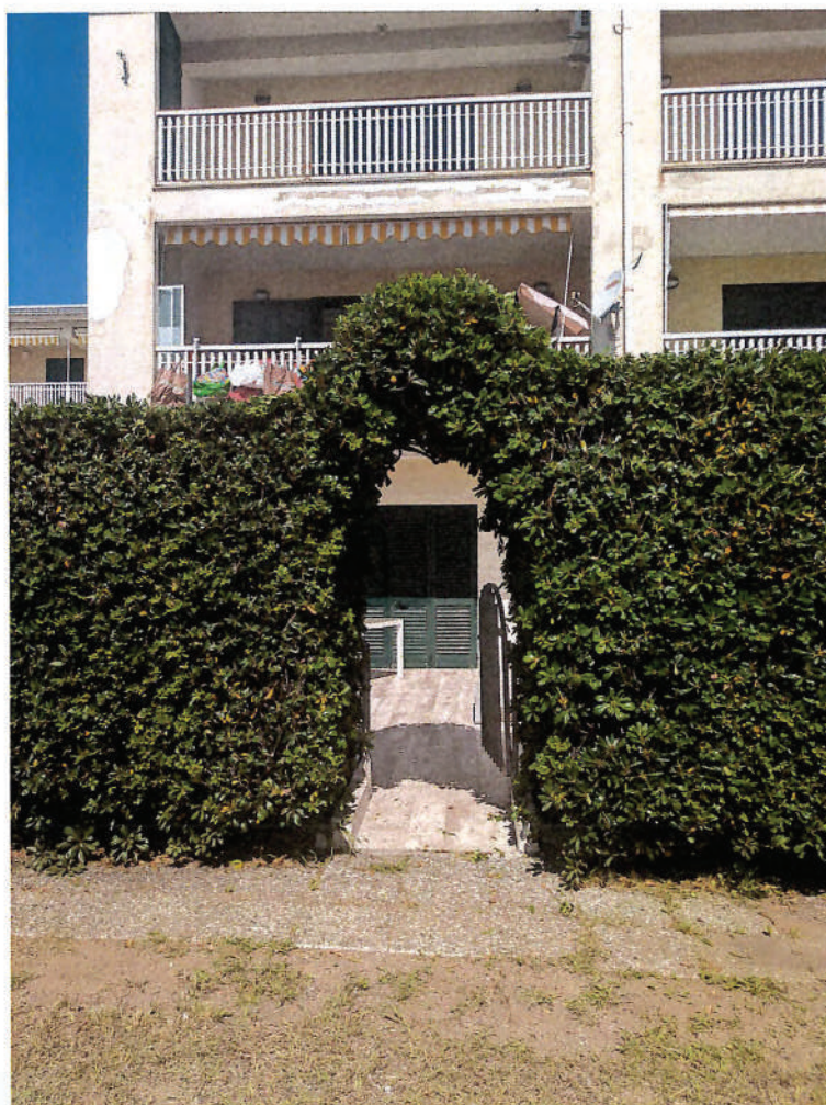
Foto n° 11 - Ingresso Vista Cortile Privato Esterno
