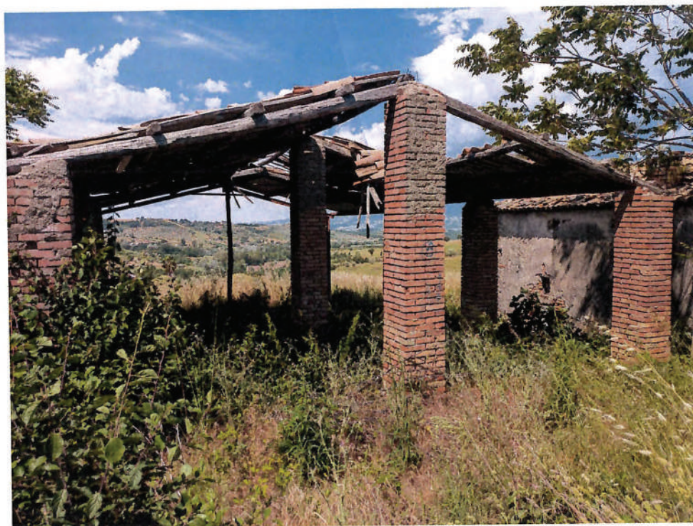
Foto n° 2 - Vista Prospetto Sud
