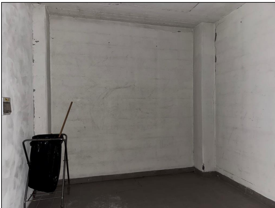
Immagine 28: Locale di deposito
