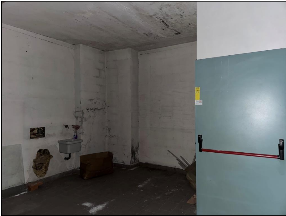
Immagine 27: Locale di deposito
