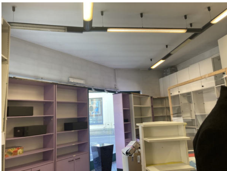
Interno negozio zona ingresso
