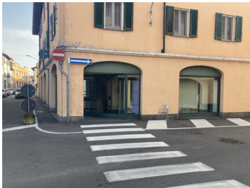
Vista da strada
