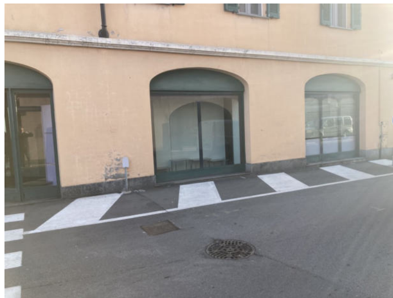
Vista da strada
