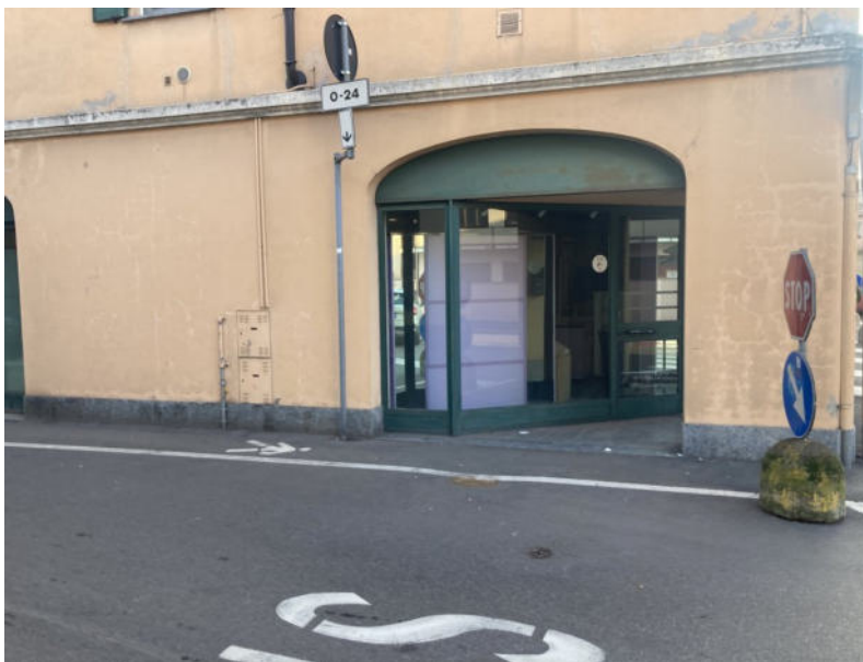
Vista da strada
