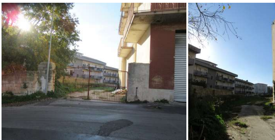
Ingresso al bene dal civico 22 del lotto n. 1
