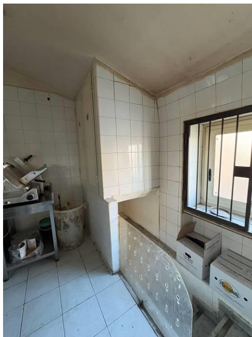
Foto 10 – Rampa d'arrivo al piano ammezzato
