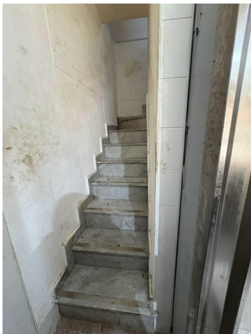
Foto 9 – Rampa di scala di piano terra per accedere al piano ammezzato
