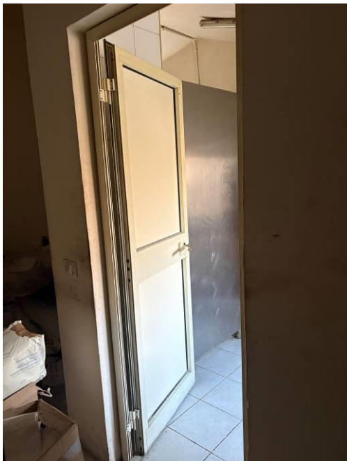
Foto 17 – Ingresso Anti-W.C. piano primo
