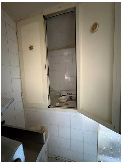
Foto 11 – Armadio in muratura piano primo
