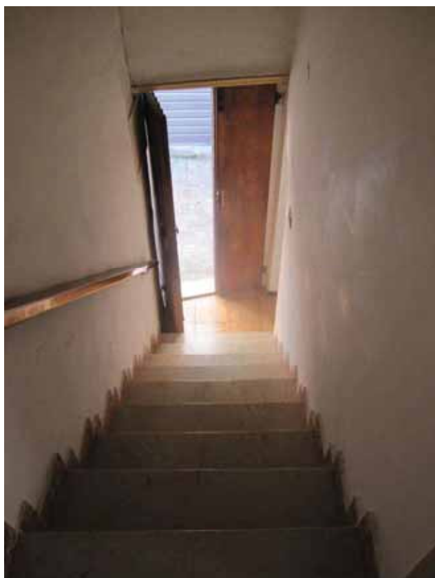
VANO SCALA INTERNO
