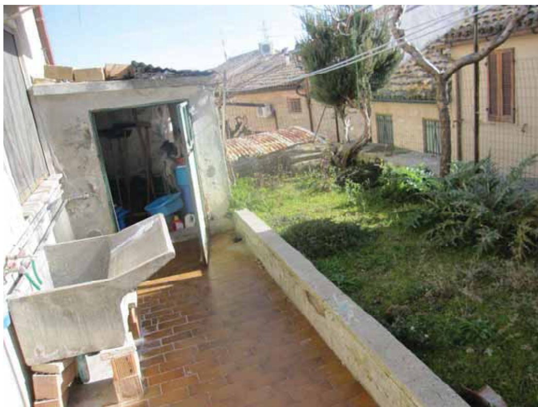
P.T. CORTILE ESTERNO – RIP. IN MURATURA
