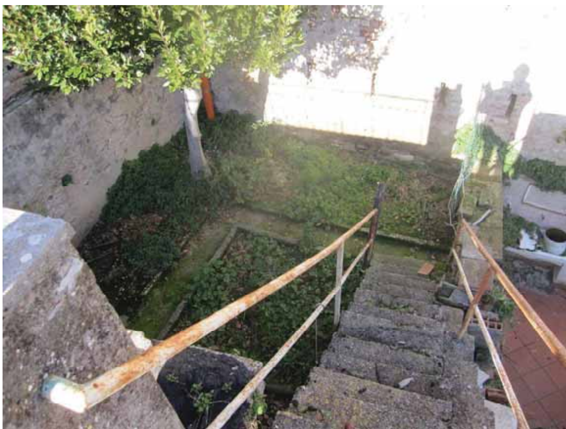
CORTILE ESTERNO – SCALA LASTRICO SOLARE
