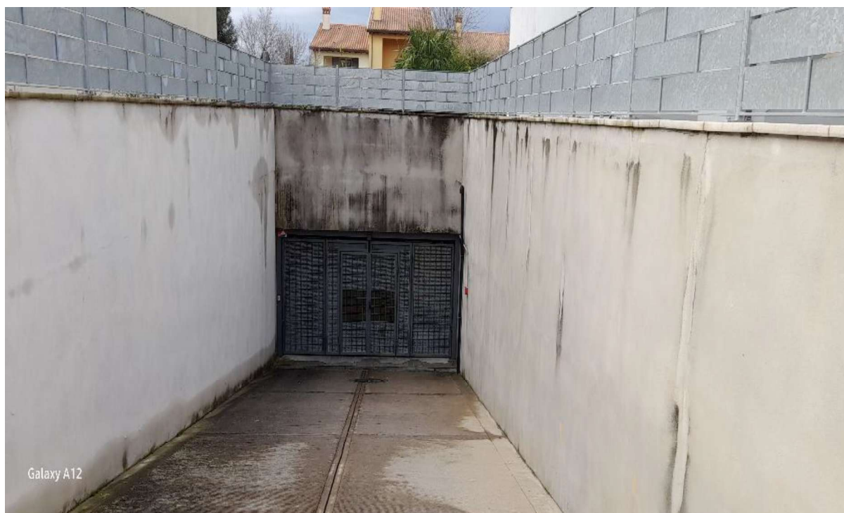
Accesso carrabile al p. 1°S sito nella 1° Traversa di via dell'Artigianato snc Unità immobiliari individuate al C.F. del comune di Spello al Foglio 44 part. n.1031
