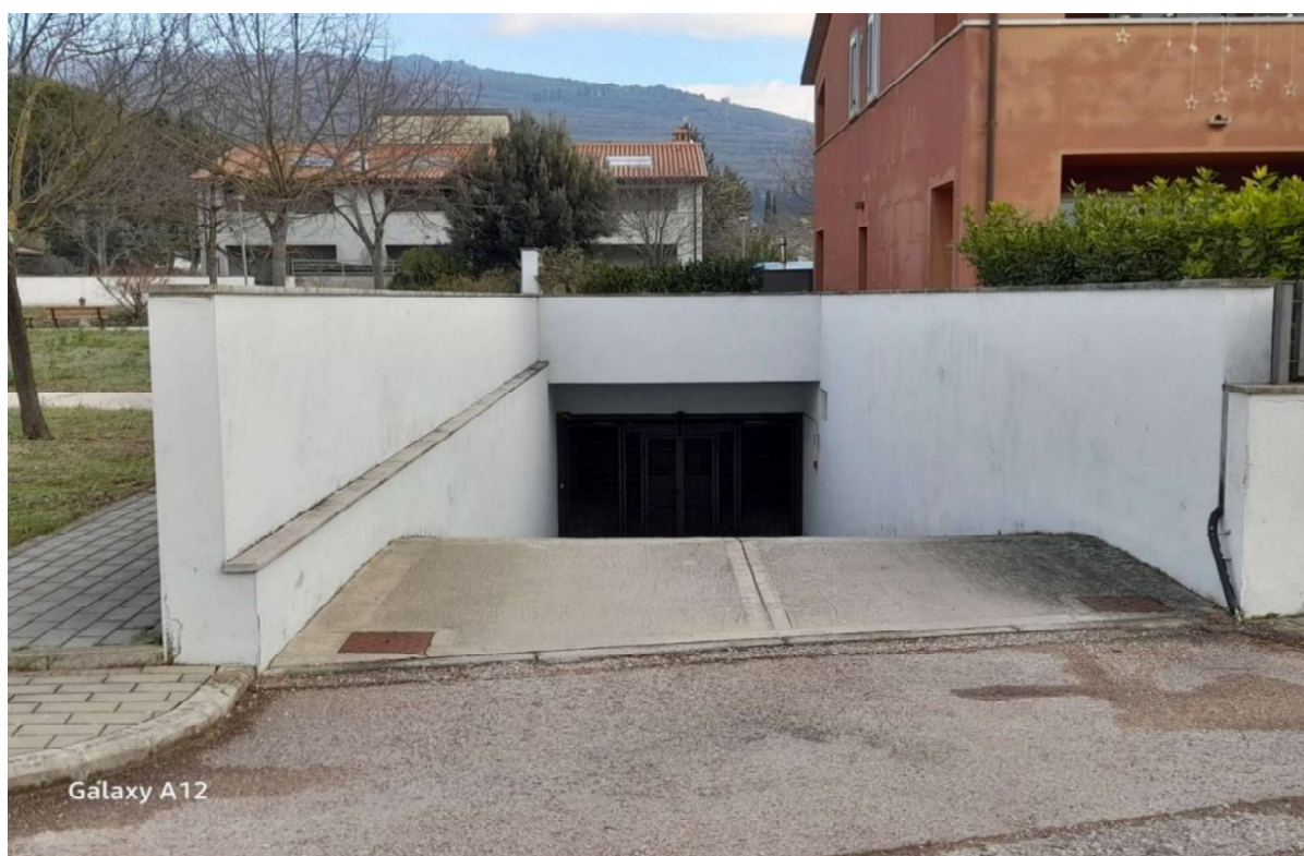
Accesso carrabile al p. 1°S sito in via dei Mercanti snc
