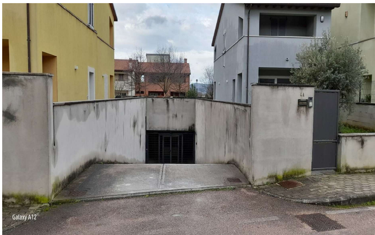
Accesso carrabile al p. 1°S sito nella 1° Traversa di via dell'Artigianato snc Unità immobiliari individuate al C.F. del comune di Spello al Foglio 44 part. n.1030
