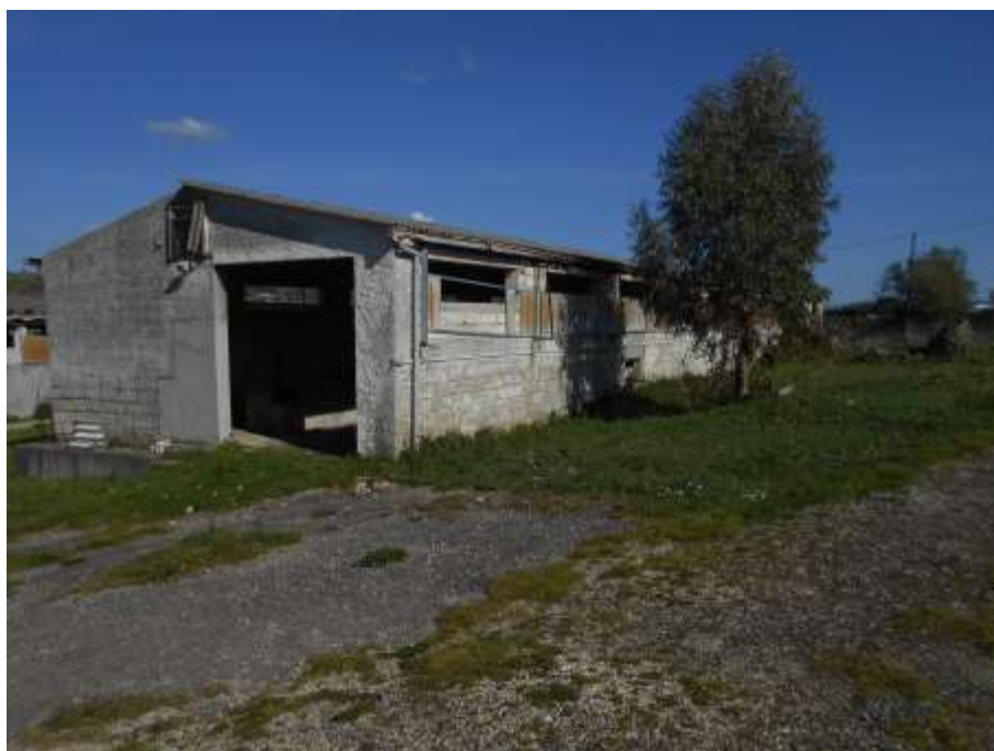
Veduta esterna edificio n.1
