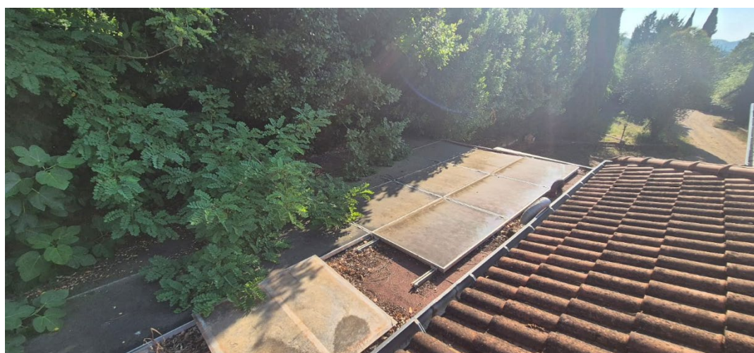
Foto 50. Tettoia sulla quale è alloggiato l'impianto fotovoltaico - fabbricato compreso nel Lotto 1
