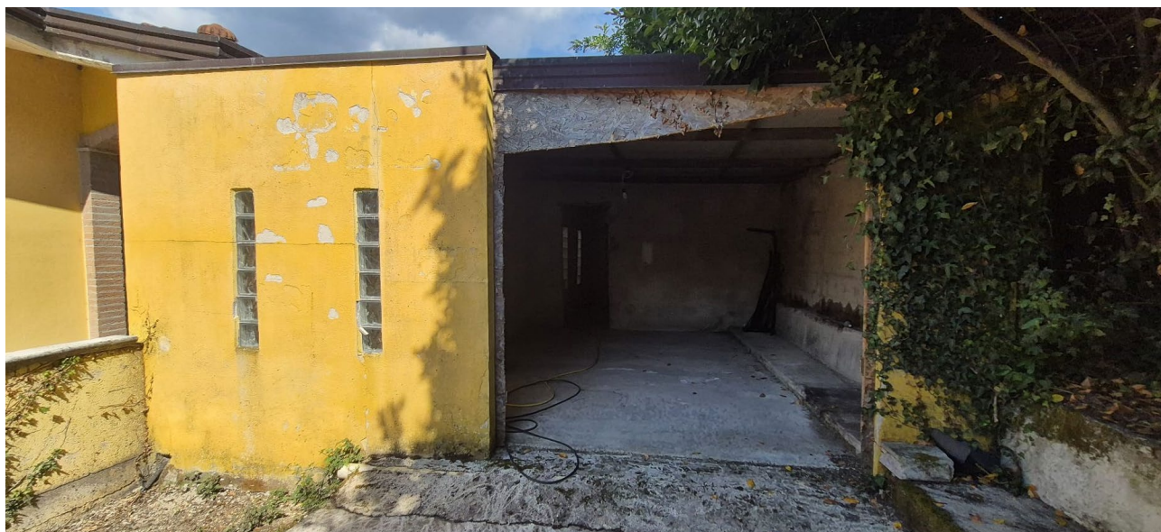
Foto 39. Tettoia sulla quale è alloggiato l'impianto fotovoltaico chiusa su 4 lati - fabbricato compreso nel Lotto 1
