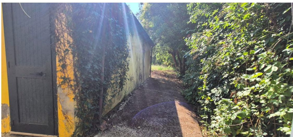
Foto 11. Porzione laterale fabbricato compreso nel Lotto 1
