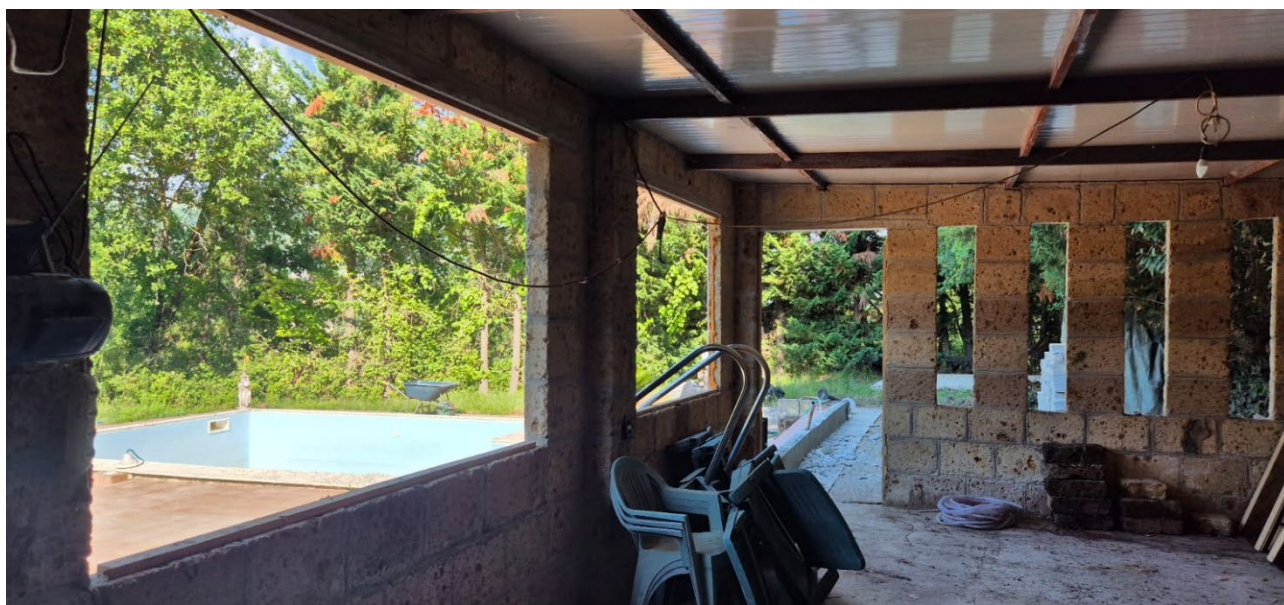
Foto 46. Locali deposito sottostanti la tettoia sulla quale è alloggiato l'impianto fotovoltaico chiusa su 4 lati (lato posteriore adiacente a vasca/piscina)- fabbricato compreso nel Lotto 1
