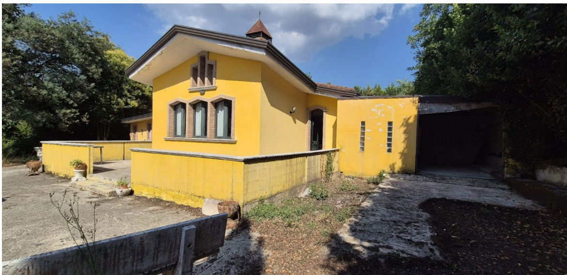
Foto 10. Prospetto principale fabbricato compreso nel Lotto 1
