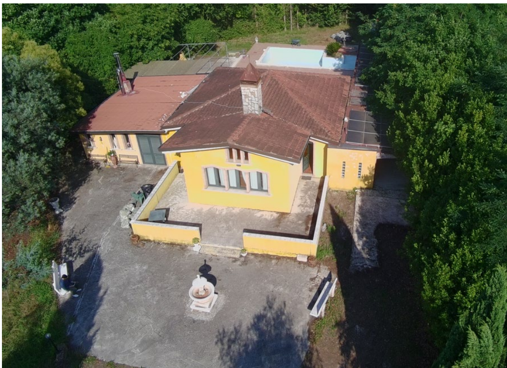
Foto 7. Vista dall'alto del fabbricato compreso nel Lotto 1
