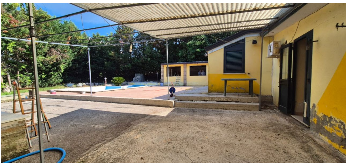
Foto 11. Prospetto posteriore fabbricato compreso nel Lotto 1
