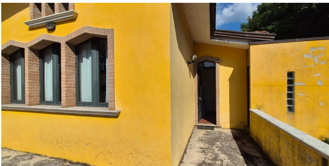
Foto 14. Ingresso al fabbricato compreso nel Lotto 1
