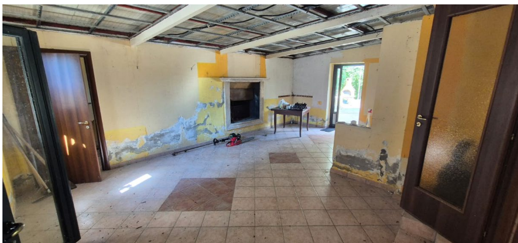
Foto 34. Salone pertinenziale al fabbricato principale (particolare camino) - fabbricato compreso nel Lotto 1
