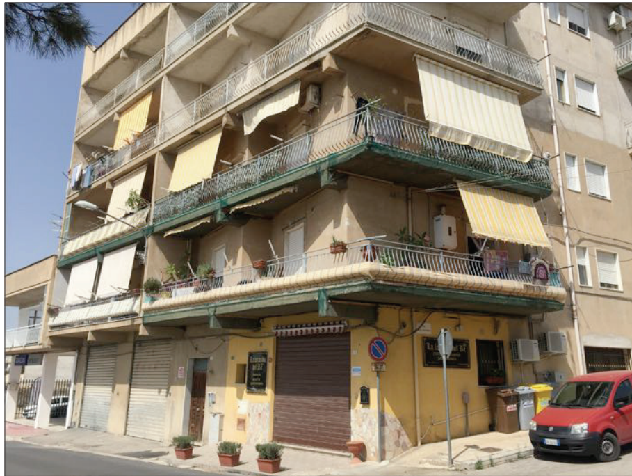
Foto n.1 - prospetto del fabbricato prospiciente la via Lioni
