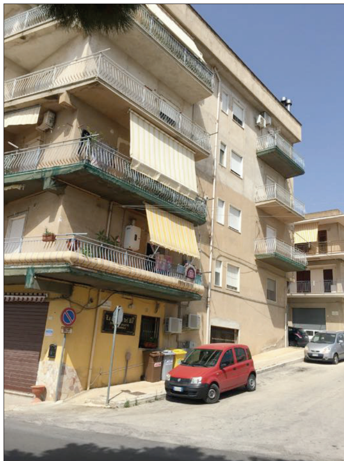
Foto n.2 - prospetto del fabbricato prospiciente la via Vasco de Gama
