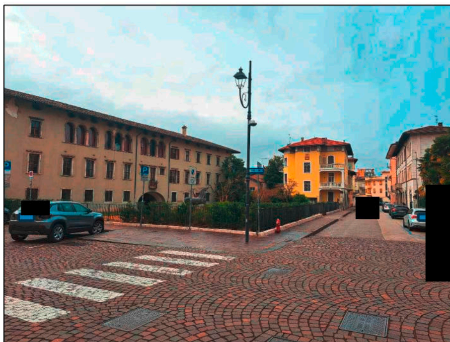
FOTO 02: p.ed. 154/1 (in superficie) con sottostante autorimessa p.ed. 2249, posta sull'incrocio fra via Tartarotti e Via Carducci (presa da nord).
