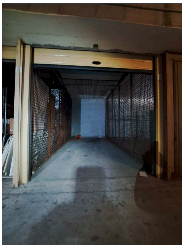
FOTO 10: sub. 2, P.M. 2, box auto lato sud in data 24.03.2026 (presa da ovest).
