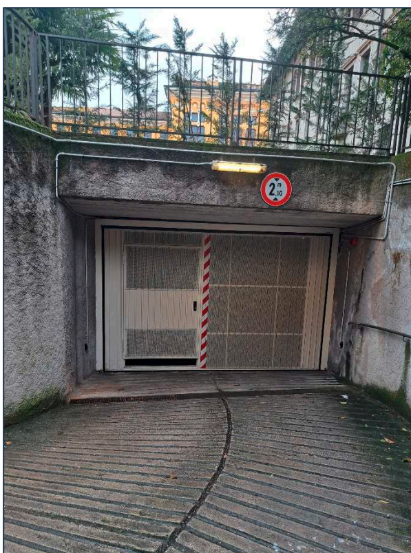
FOTO 06: chiusura metallica basculante a movimentazione automatizzata, pedonale e carrabile, di accesso al piano primo sottostrada della p.ed. 2249 (presa da sud).
