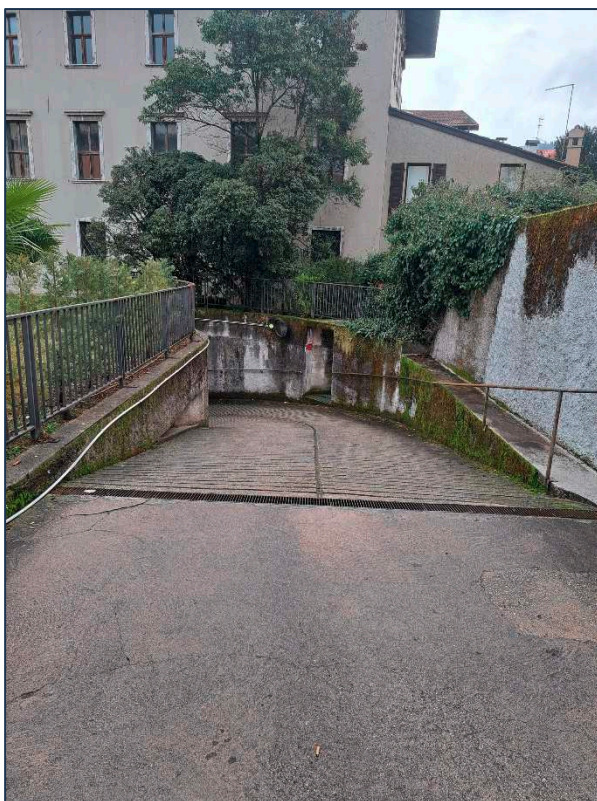
FOTO 05: tratto iniziale della discenderia di accesso all'autorimessa sottostrada (p.ed. 1274/1), regolato da lanterna semaforica (presa da nord-ovest).
