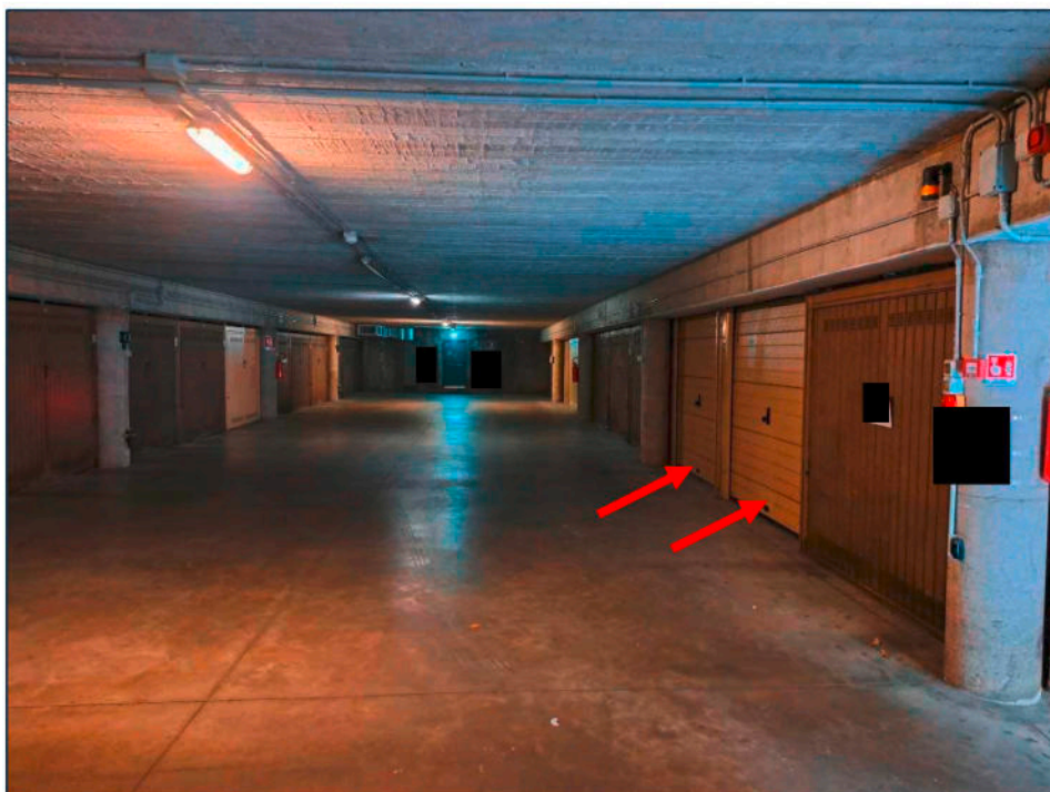
FOTO 08: corsia di manovra comune a piano primo sottostrada, con evidenza dei box auto oggetto di esecuzione (presa da sud).
