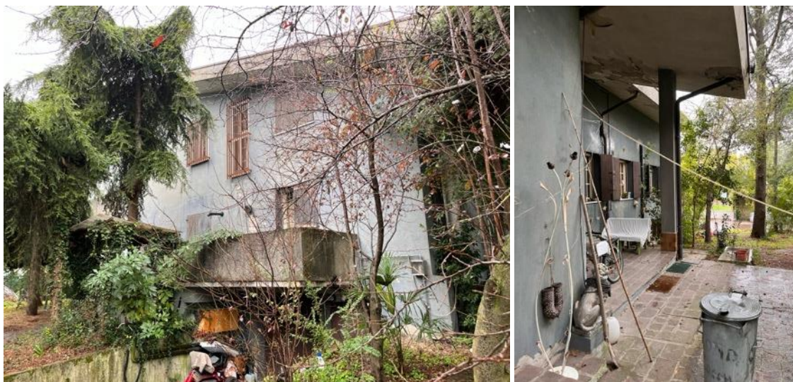
7. Facciata est, e nord con accesso principale non visibile.
