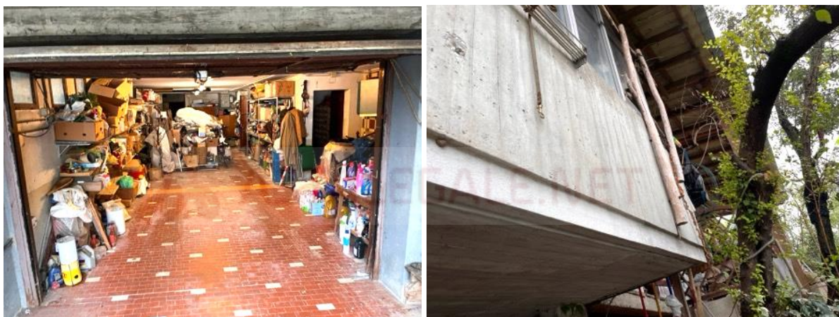
8. Seminterrato e facciata ovest.
