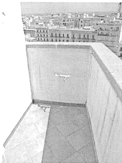
Foto n. 23 – terrazzino camera da letto 1
