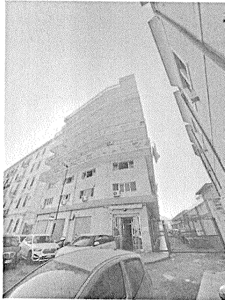
Foto b) cancello d'ingresso da Serraglio Vecchio
