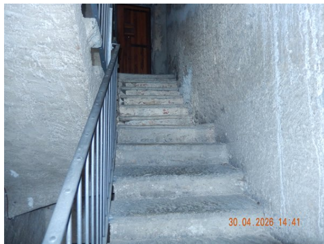
Scale di accesso al piano 1°
