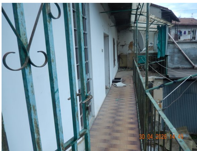
Accesso locali 1° piano da ballatoio
