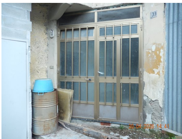
Porta accesso locale sgombero p.t.
