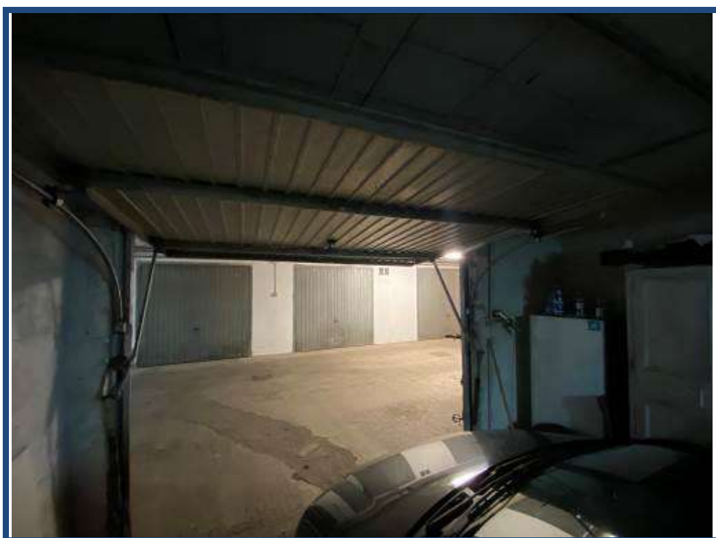
Foto 22 – Vista del garage al piano seminterrato.
