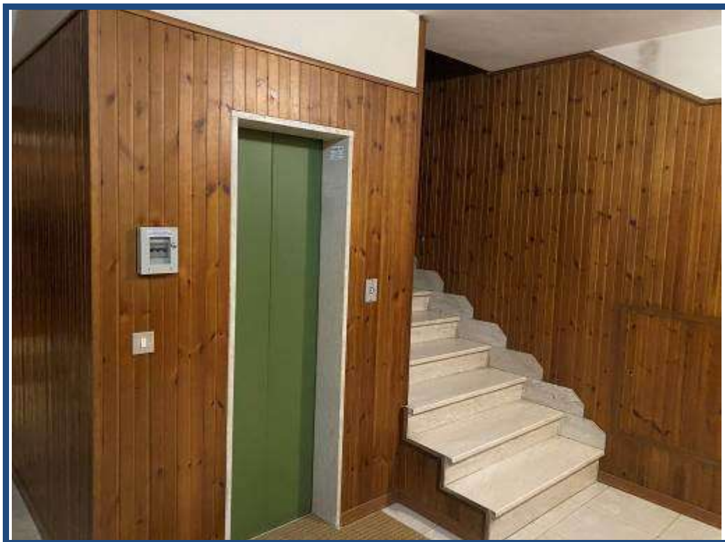
Foto 5 – Vista interna del vano scala condominiale con ascensore.
