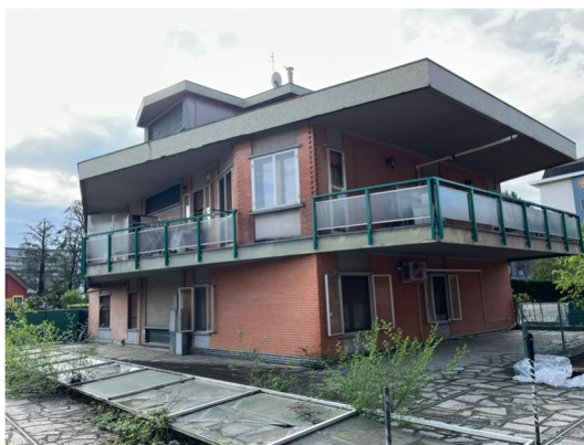
VISTA ESTERNA STABILE
