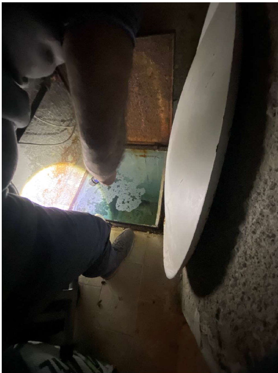
Vista vasca idrica e livello acqua a sfioro pavimento
