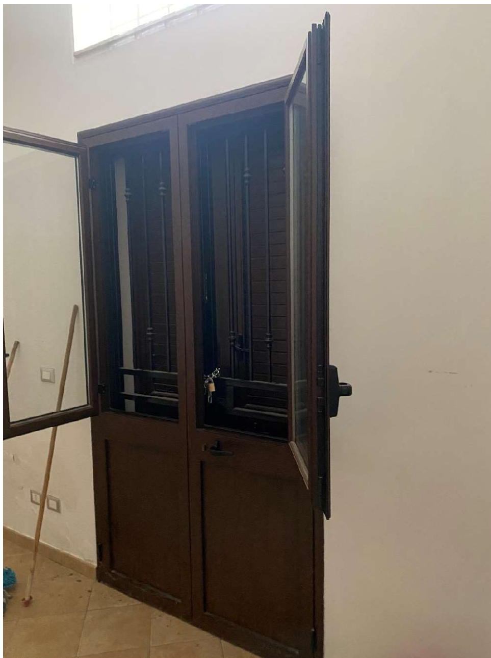
Vista ingresso locale di sgombero chiusa con lucchetto dopo l'accesso all'immobile
