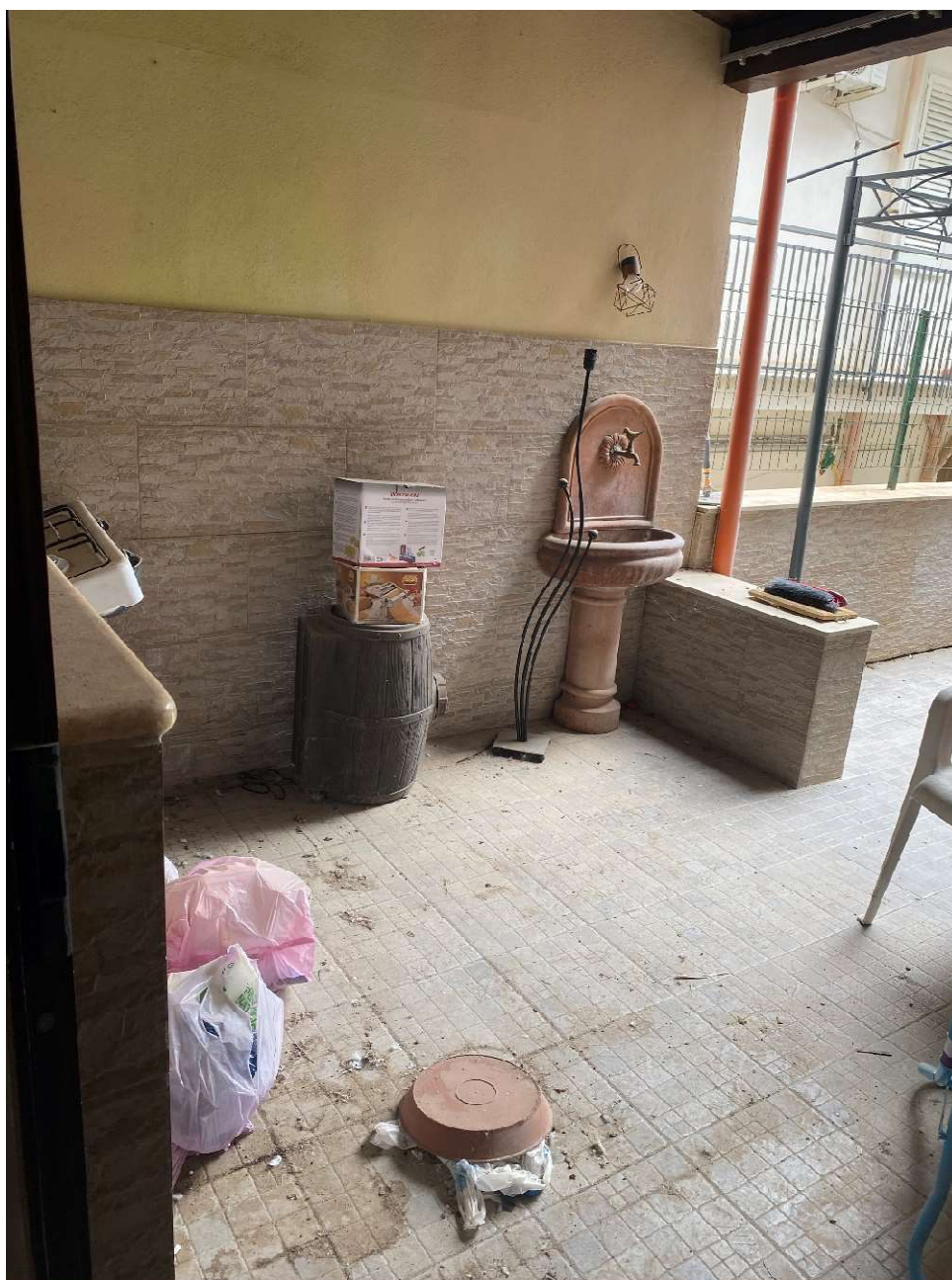
Vista porzione del cortile sul retro prospetto adibita a terrazza coperta a tettoia
