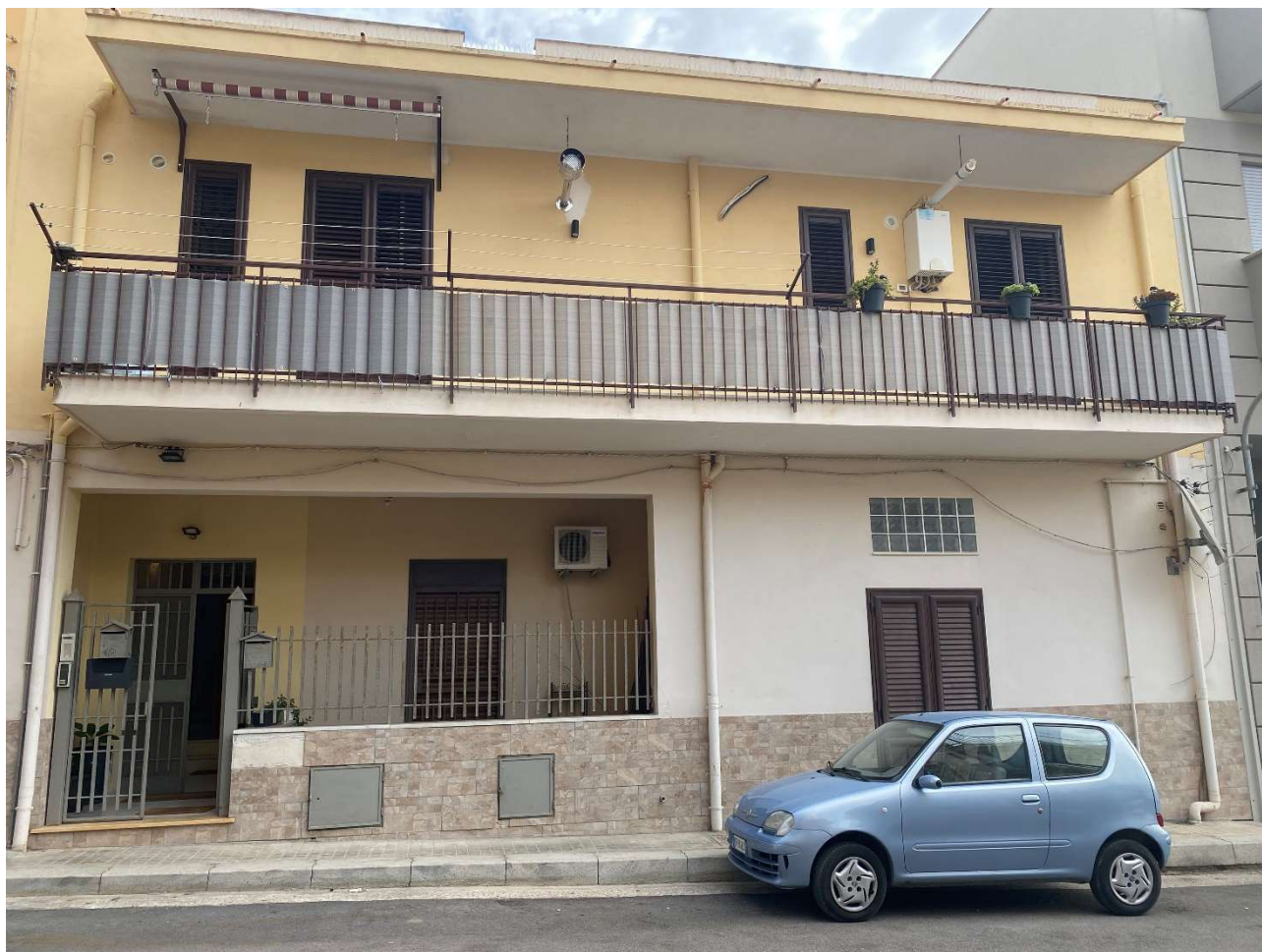
Vista prospetto sud dalla via Donizzetti, Porticato di ingresso a Porticato esclusivo dell'abitazione su cui si affaccia la prima camera da letto. Vista ingresso del locale di sgombero al civ 40
