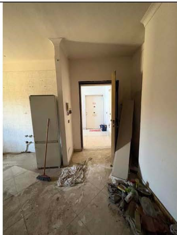
Fotografia n. 8 _ Ingresso al LOTTO UNICO
