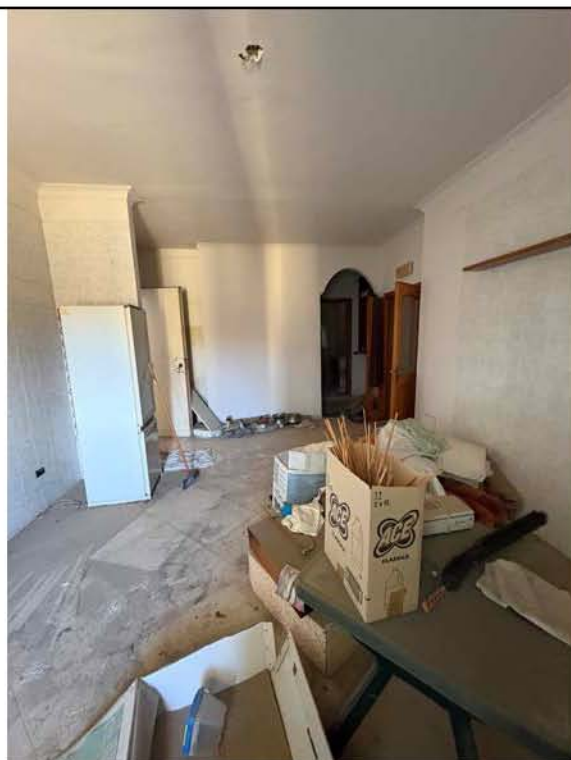
Fotografia n. 9 _ Vano n.1 vista sud/nord
