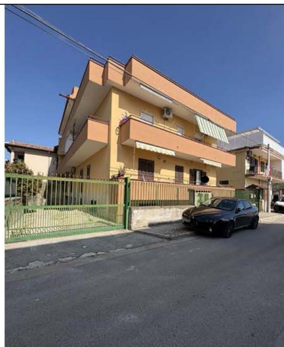
Fotografia n. 2 _ Prospetto nord/ovest del fabbricato
