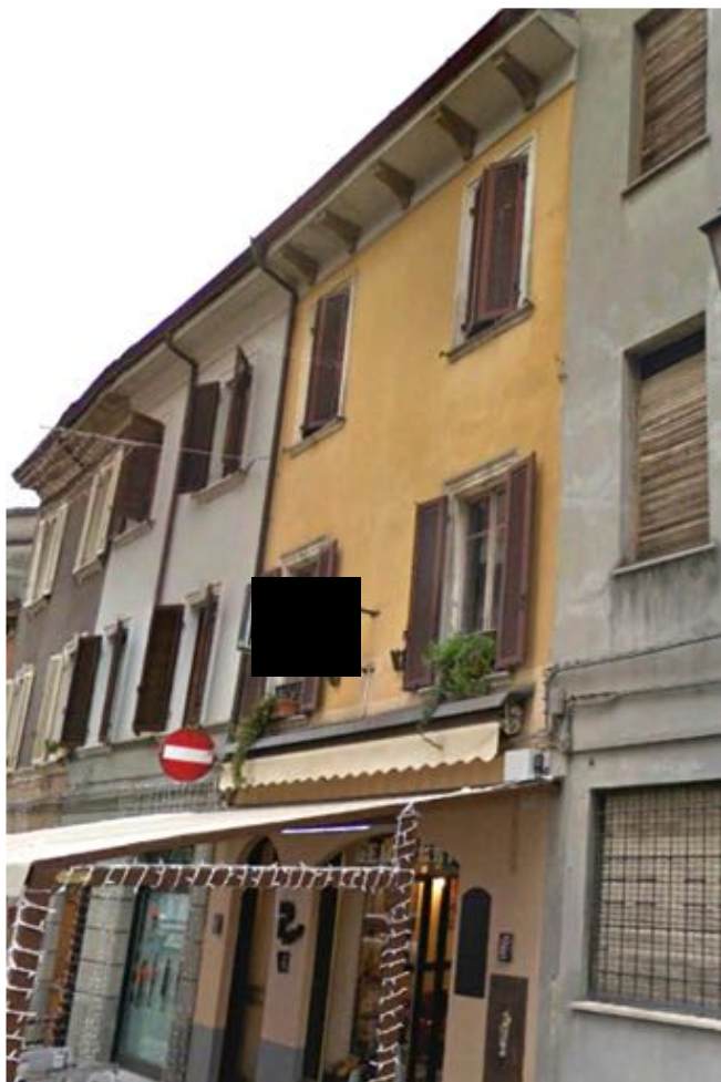
Esterno – via XX Settembre
