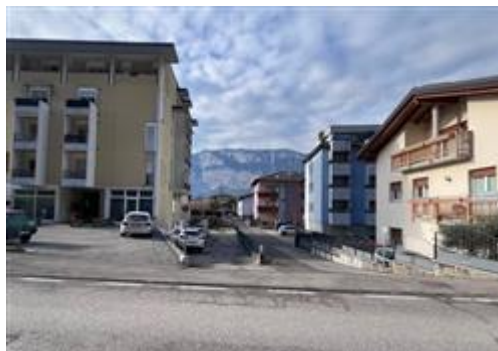
Accesso da nord
