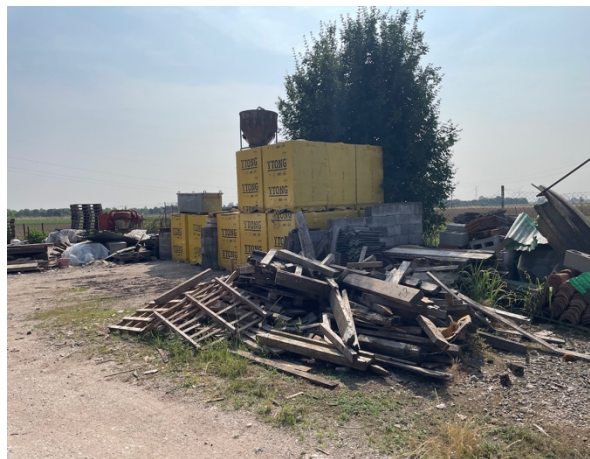
Area esterna di pertinenza
