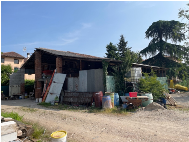
Esterno lato Sud
