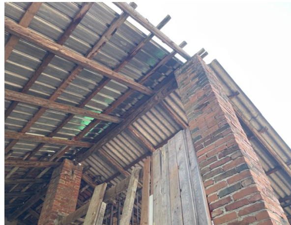
Copertura parte principale
