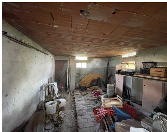
Interno – deposito lato Nord-Est piano terra
