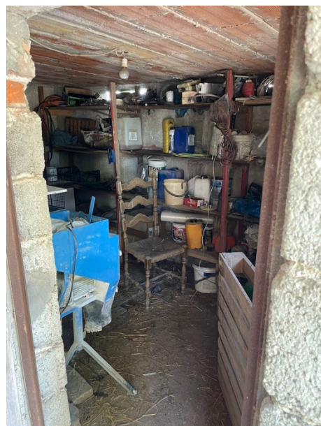
Interno – deposito lato Sud-Ovest piano terra
