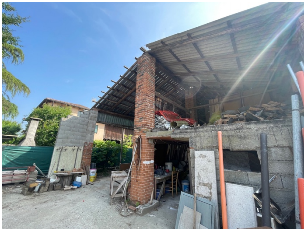
Esterno lato Sud-Ovest
