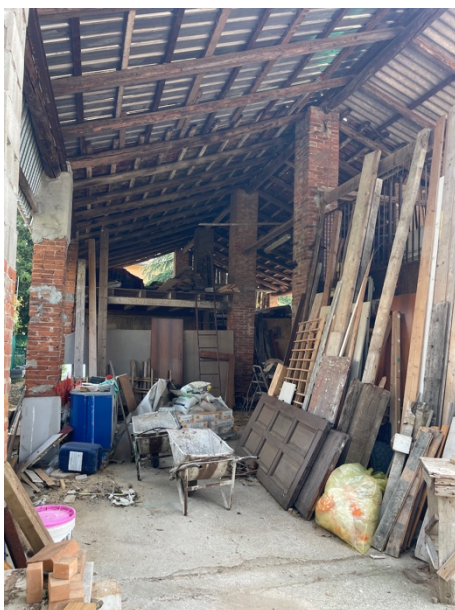
Ingresso deposito lato Sud-Ovest piano terra
