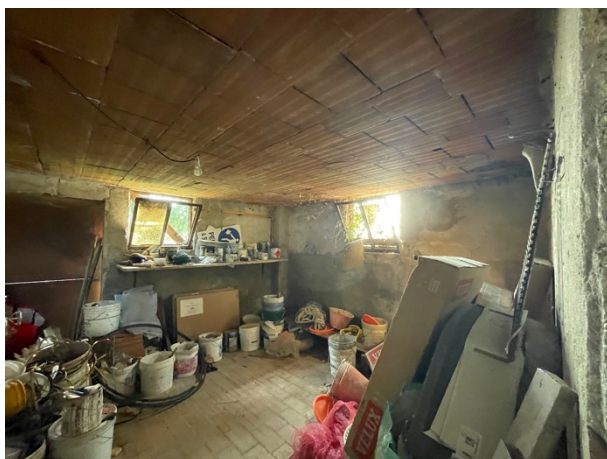
Interno – deposito lato Nord-Est piano terra
