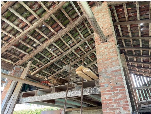
Deposito piano primo e Copertura parte principale
