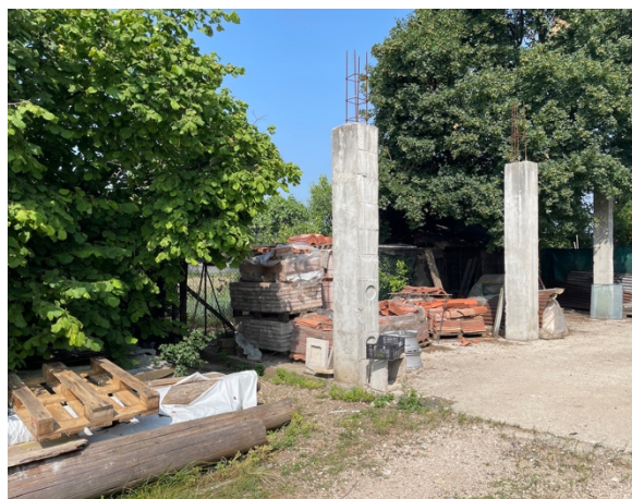
Area esterna di pertinenza
