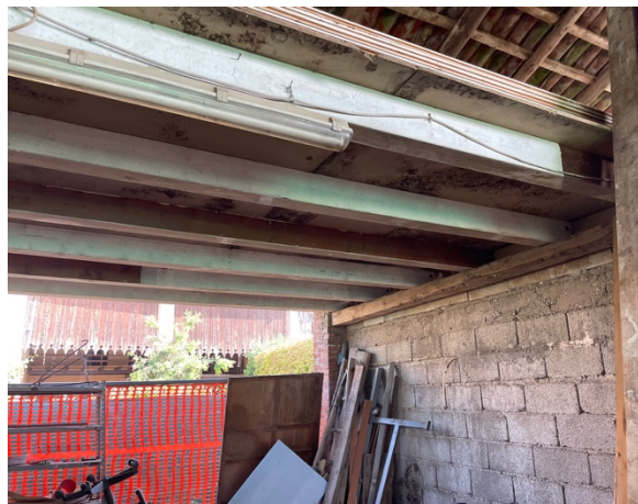
Interno – deposito parte principale piano terra
