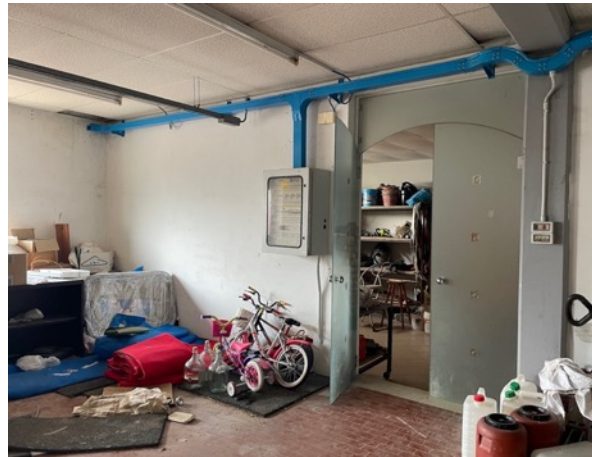
Laboratorio piano terra – con porta di collegamento con A.U.I.
