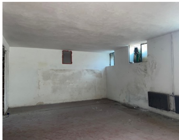
Magazzino piano interrato
