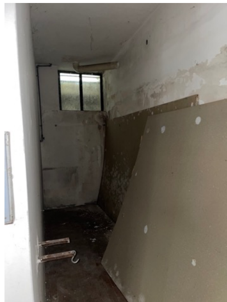
Zona deposito adiacente al vano scala
