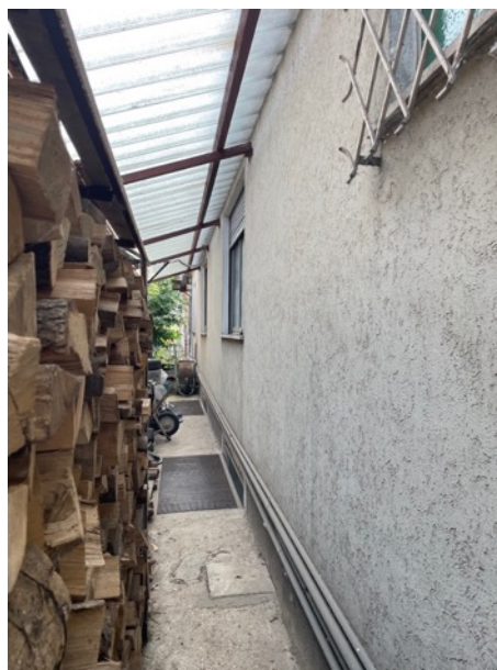
Esterno lato Nord-Ovest
