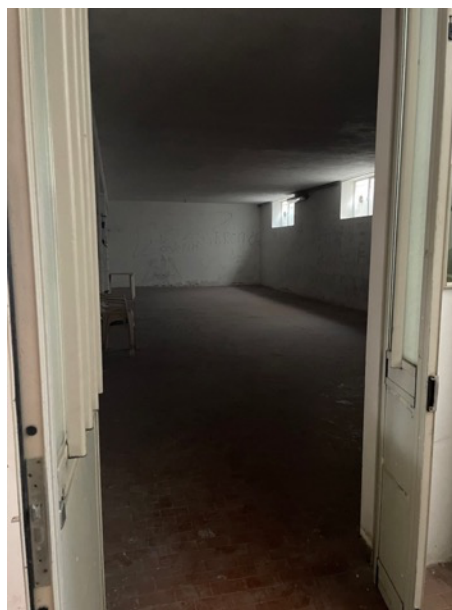
Magazzino piano interrato
