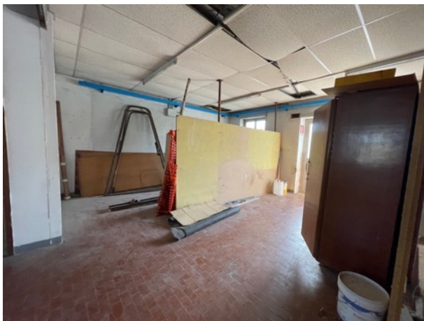
Ingresso Laboratorio piano terra
