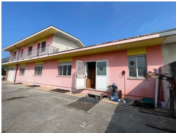
Esterno lato Sud-Est – ingresso Laboratorio
