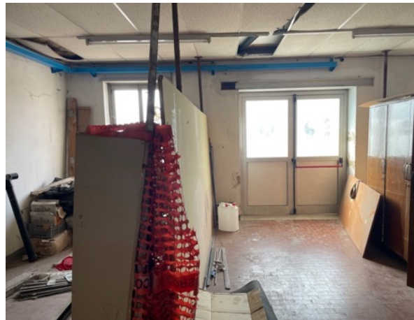
Ingresso Laboratorio piano terra
