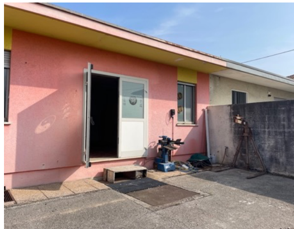
Esterno lato Sud-Est
