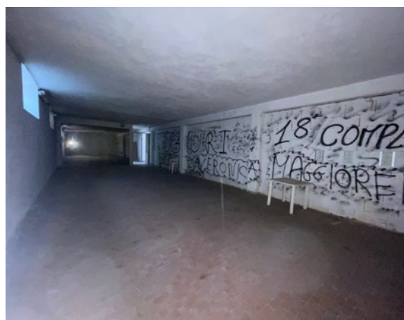
Magazzino piano interrato
