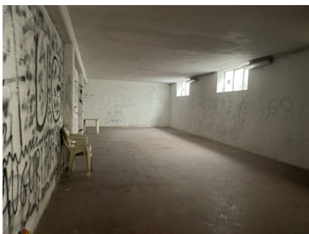
Magazzino piano interrato
