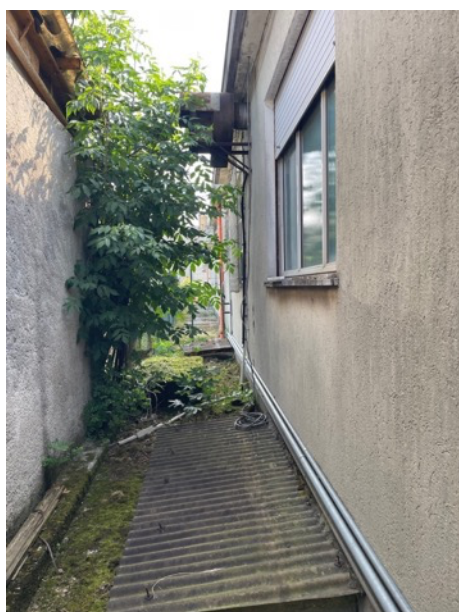
Esterno lato Nord-Ovest
