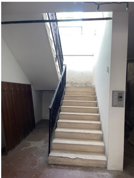
Vano scala di accesso al piano terra
